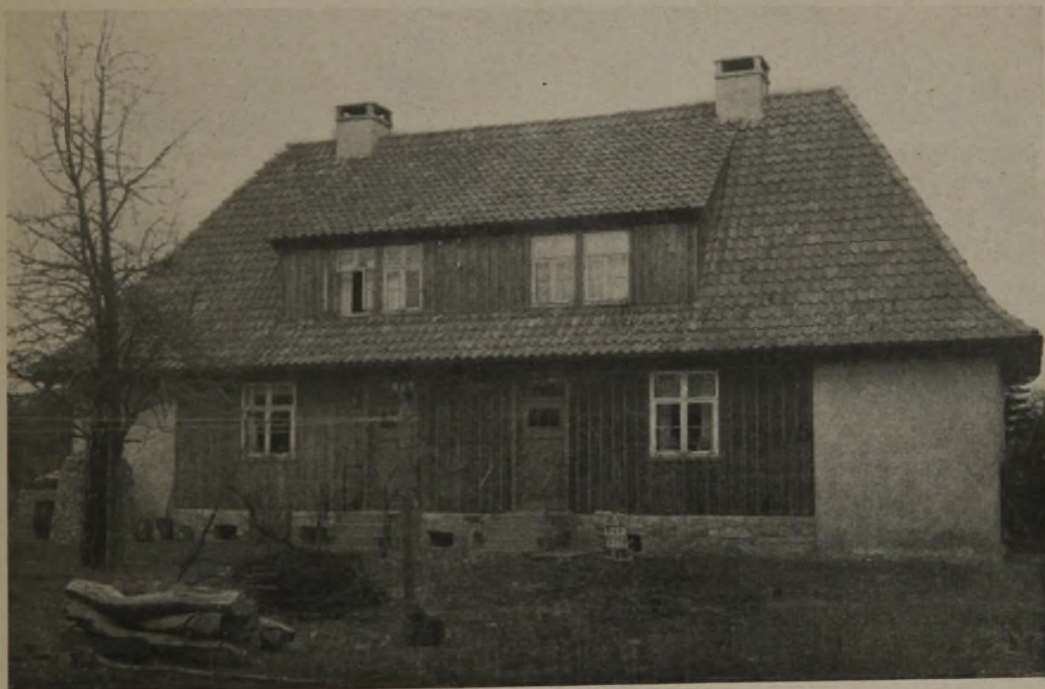
Abb. 1a. Arbeiter-Doppelwohnhaus auf dem Staatsgut Steterburg. Erbaut 1921.
