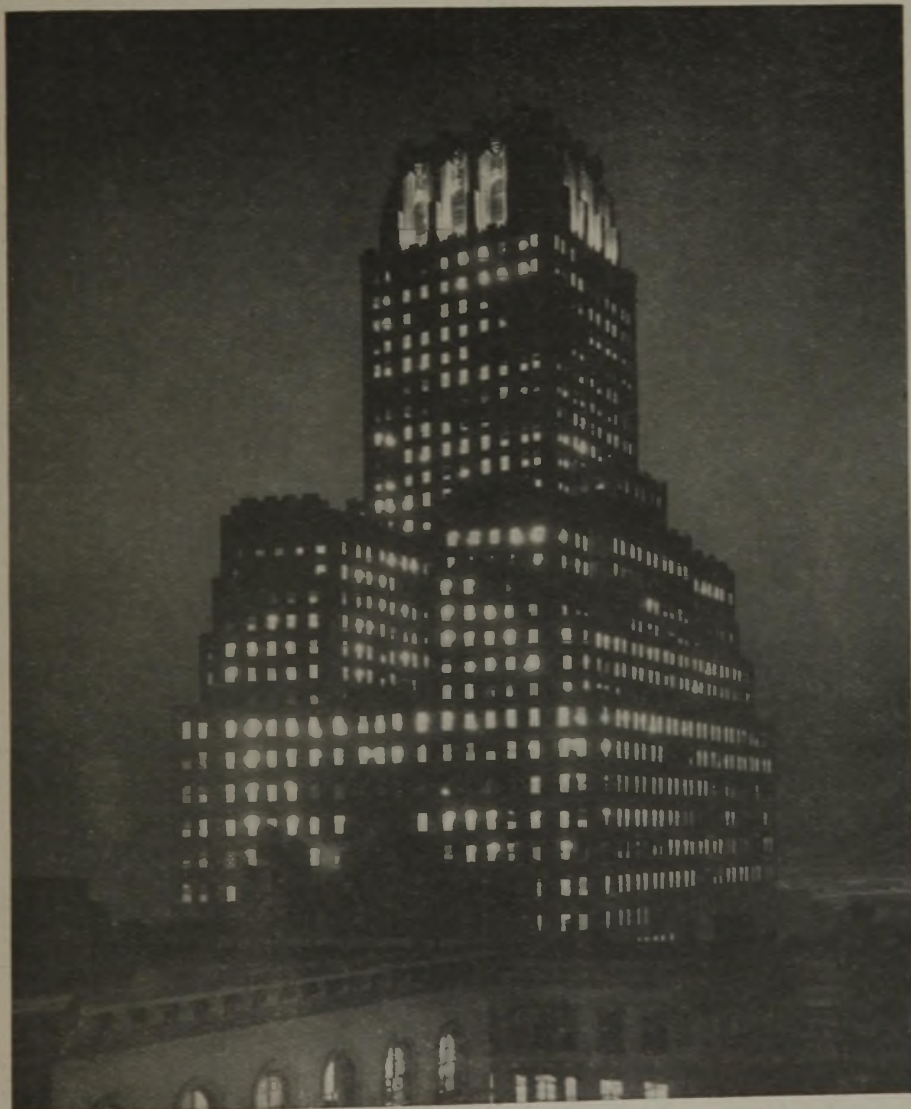
Abb. 1. New York Telephone Building bei Nacht. Photographie: The New York Edison Company, New York.
