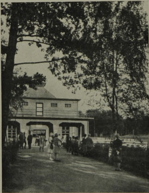
Abb. 6. Seitliche Ansicht des Betriebs-Gebäudes.
