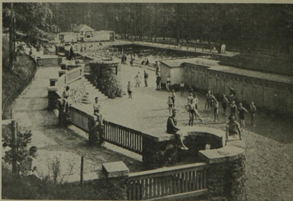
Abb. 4. Blick über die Terrassen hinweg zum Schwimmbecken.
