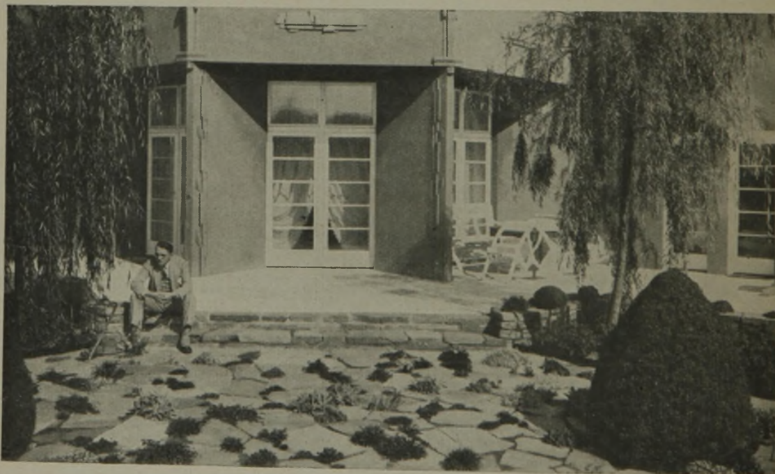
Abb. 1. Dachgarten-Terrasse in der Sachs-Allee in Dahlem bei Berlin.
