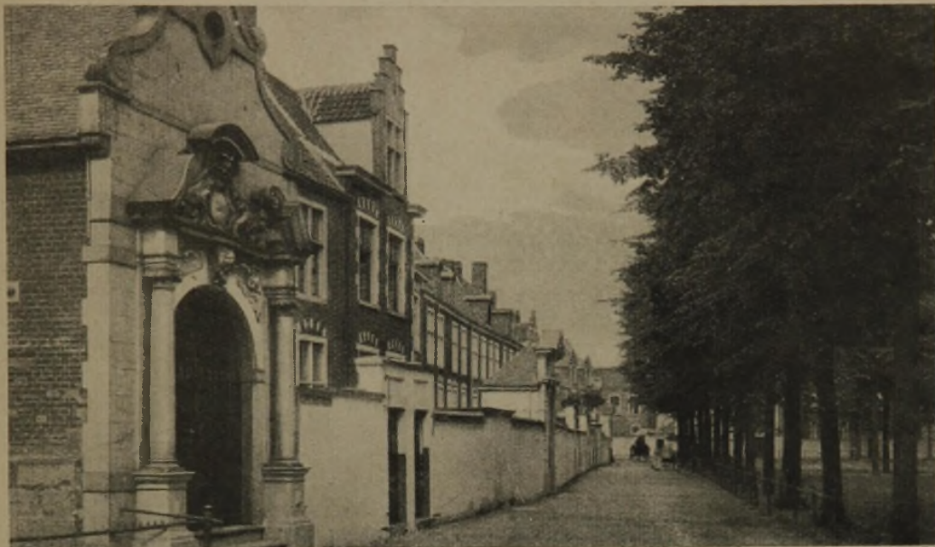
Abb. 3. Blick in den baumbestandenen Hofplatz.
