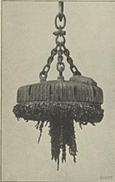
Abbildung 3. Heben von Lochputzen.
