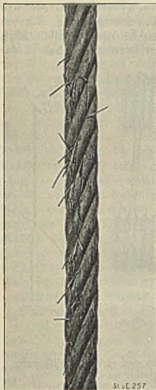
Abbildung 5. Beschädigung des Seiles auf der ganzen Länge in Form eines Bandes.
