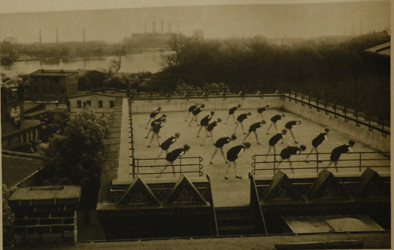
DACHFLÄCHE DER DOPPELTURNHALLE VOLKSSCHULE ALT-STRALAU
