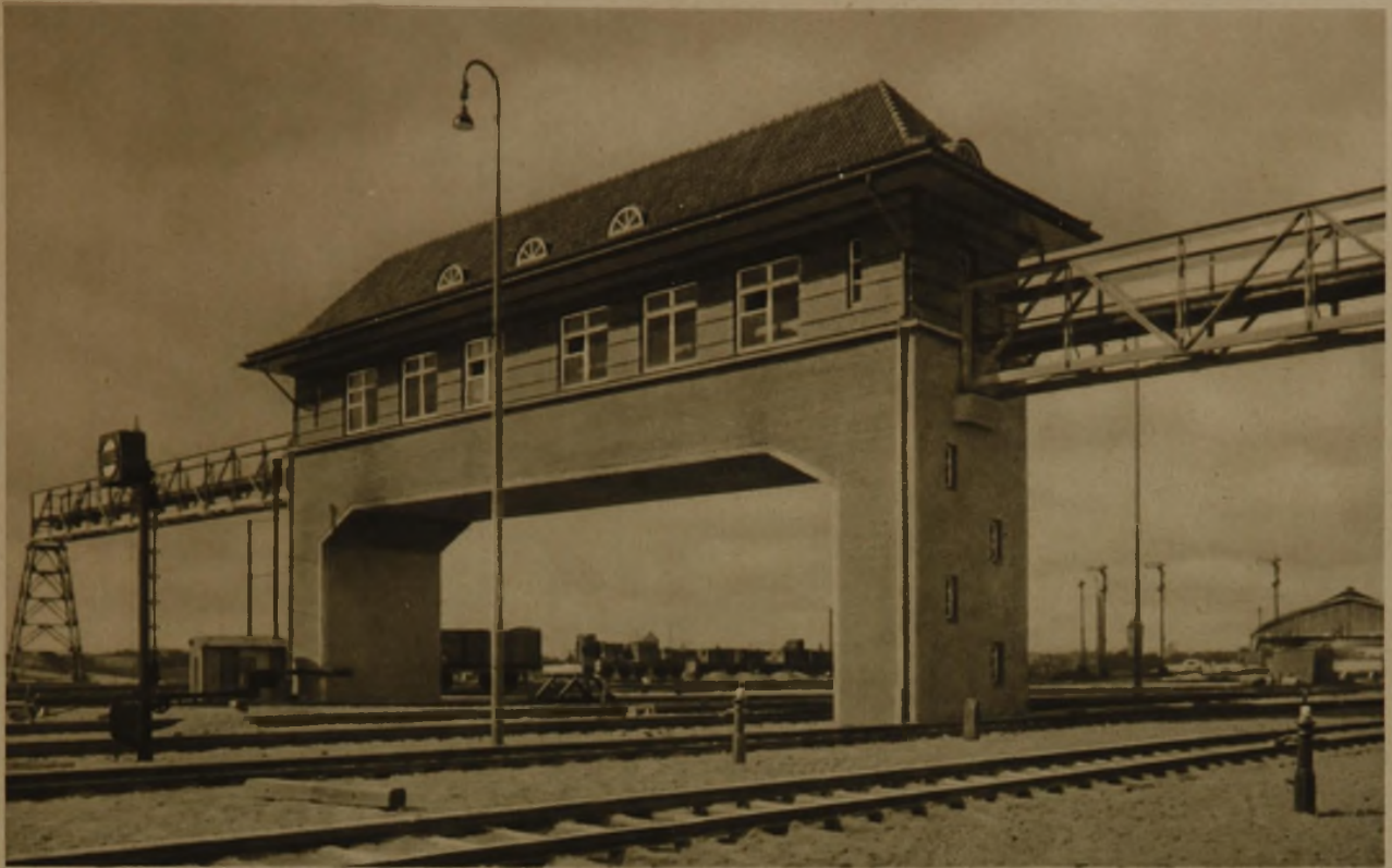
STELLWERK OSTAUSFAHRT HAUPTBAHNHOF
