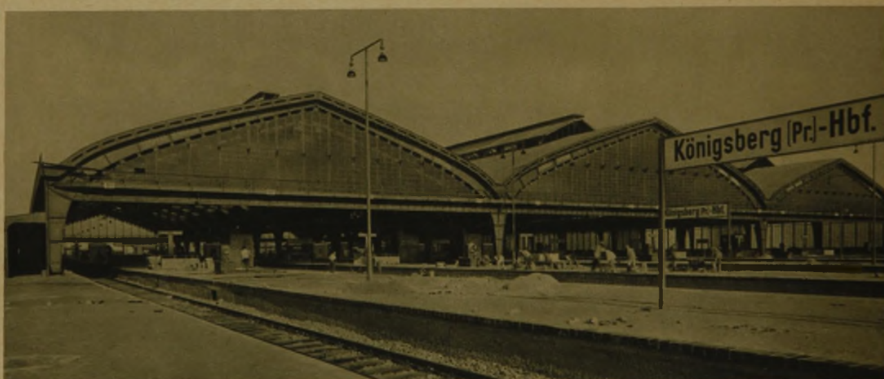
DIE DREISCHIFFIGE BAHNSTEIGHALLE
