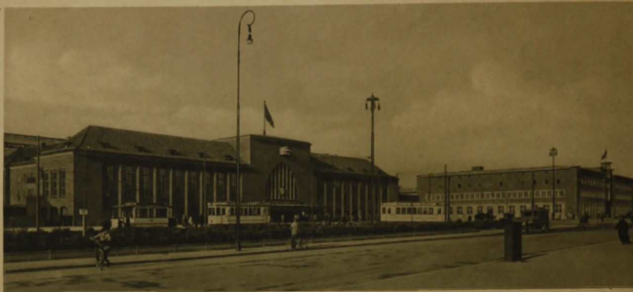
EMPFANGSGEBÄUDE UND (RECHTS) BAHNPOSTGEBÄUDE
