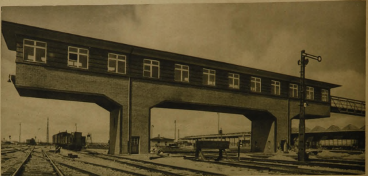
AUSSEN- UND INNENANSICHT DES REITERSTELLWERKS AM HAUPTBAHNHOF
