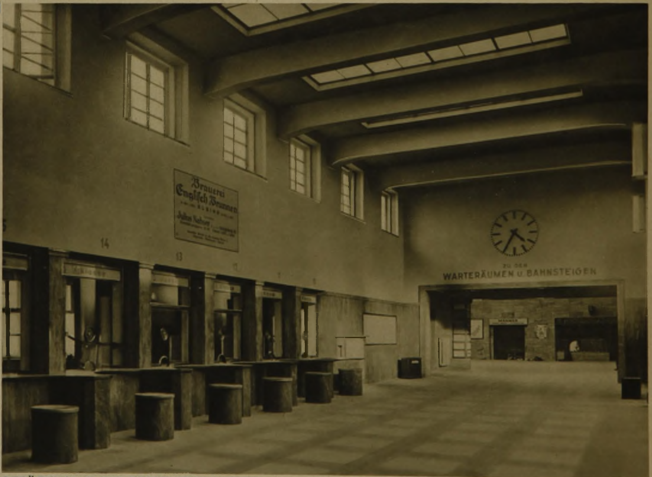
GEPÄCKHALLE MIT RESERVESCHALTERN
