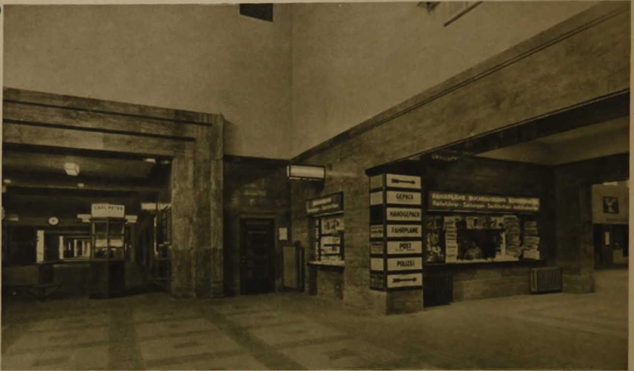
DURCHGANG VON HAUPTHALLE ZUR GEPÄCKHALLE
