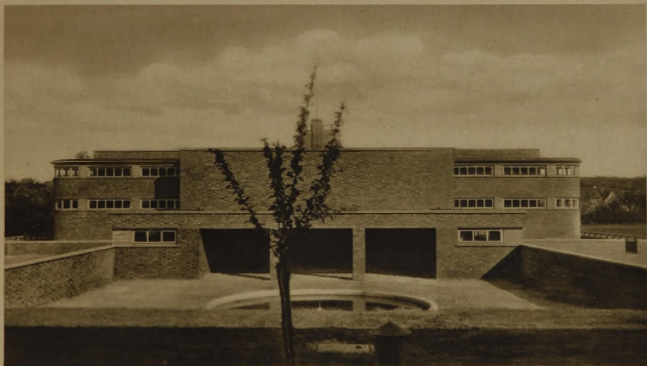
SCHULE IN UNTERTEUSCHENTHAL ARCHITEKT ERNST TROMMLER, GERA
