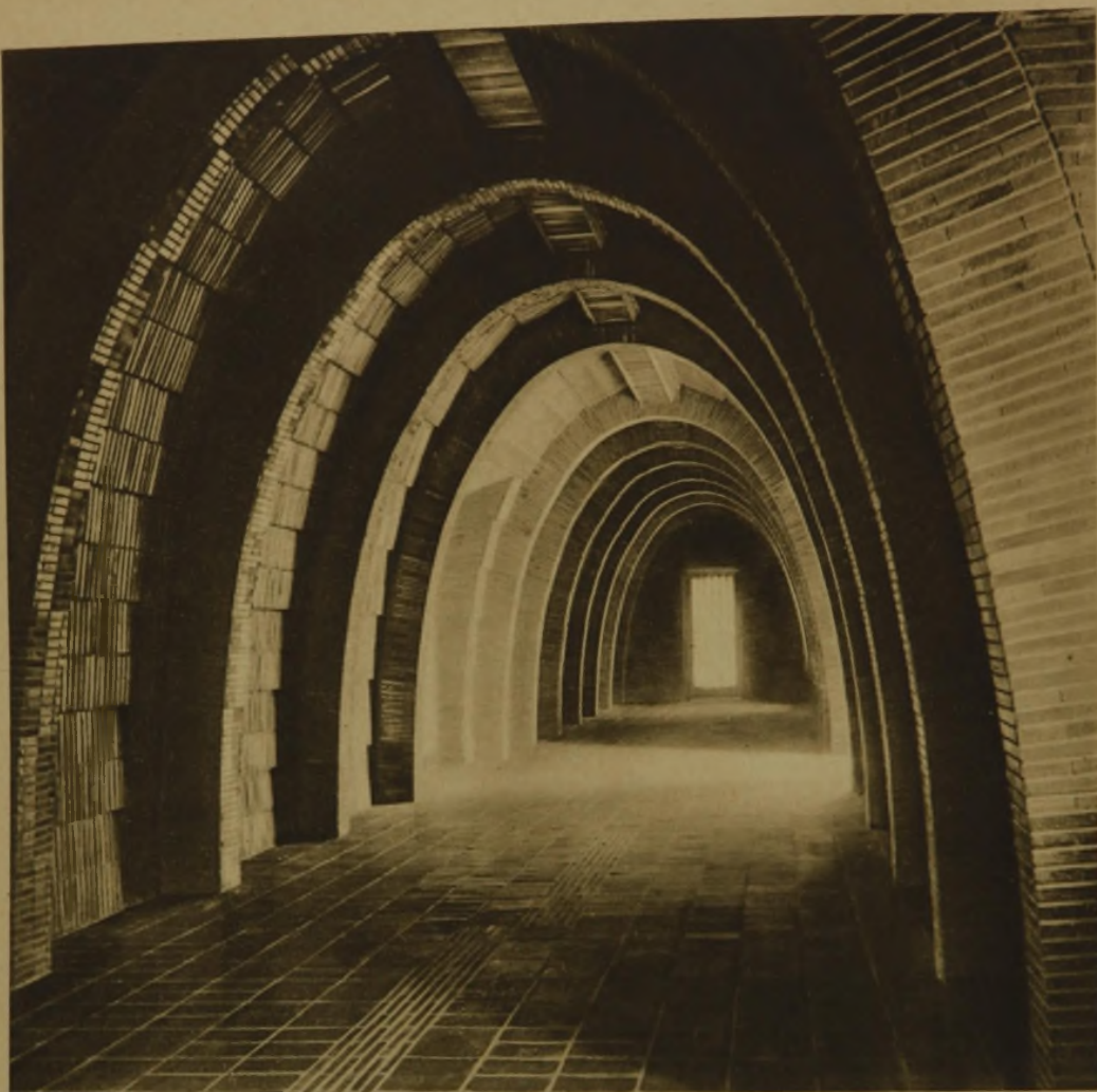
BLICK IN DIE VORHALLE
