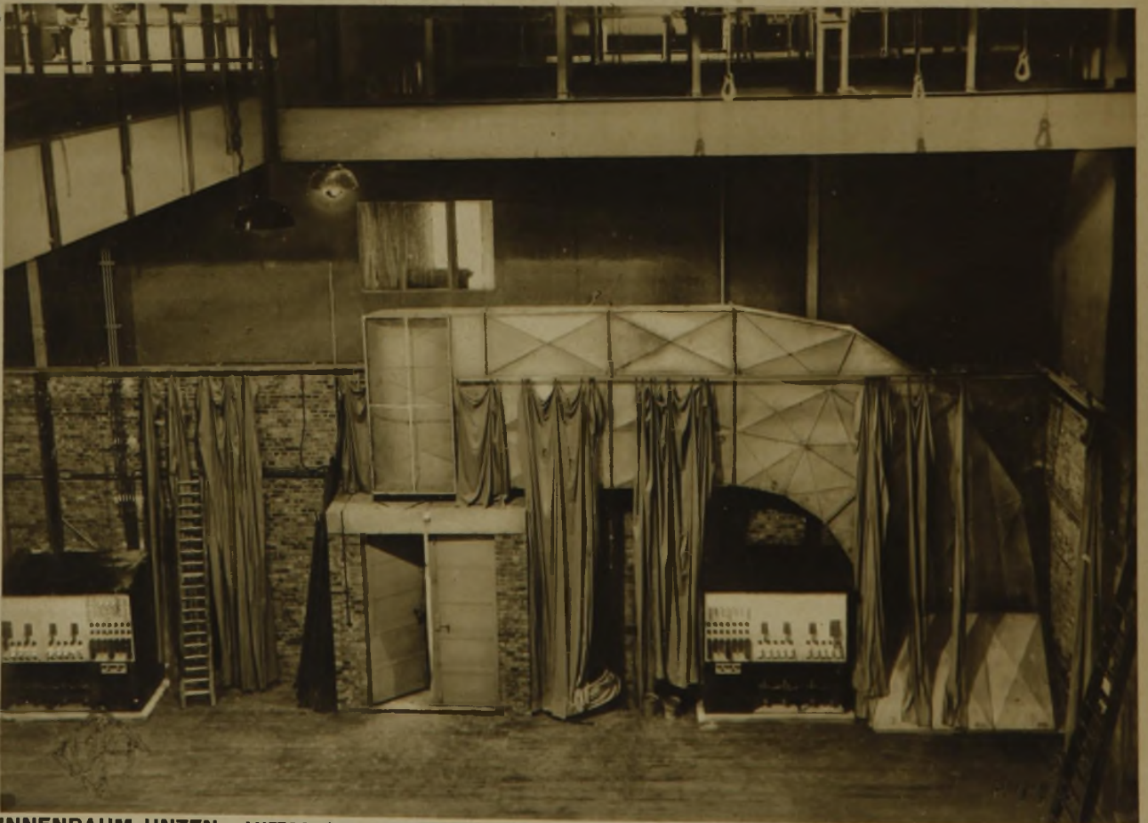
INNENRAUM UNTEN. LUFTSCHACHT, LICHTSCHALTER, VORHÄNGE ZUR SCHALLREGULIERUNG FENSTER ÜBER LUFTSCHACHTGITTER ZUM ABHÖRRaum (TONMIXER)
