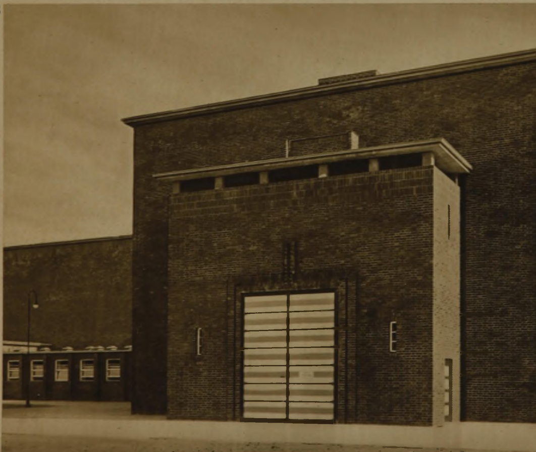
SCHMALSEITE DER WESTHALLE MIT PORTAL, DARÜBER VENTILATIONSRAUM
