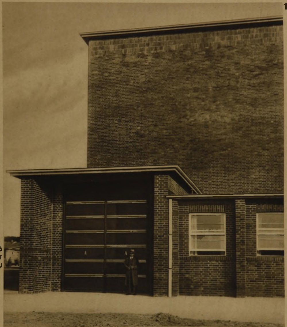
SEITENEINGANG ZUM NORDATELIER MIT GARDEROBENANBAU
