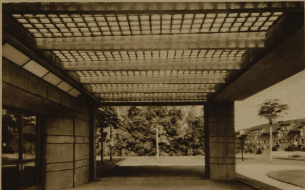
GLASPRISMEN- DECKE ÜBER DER UNTERFAHRT
