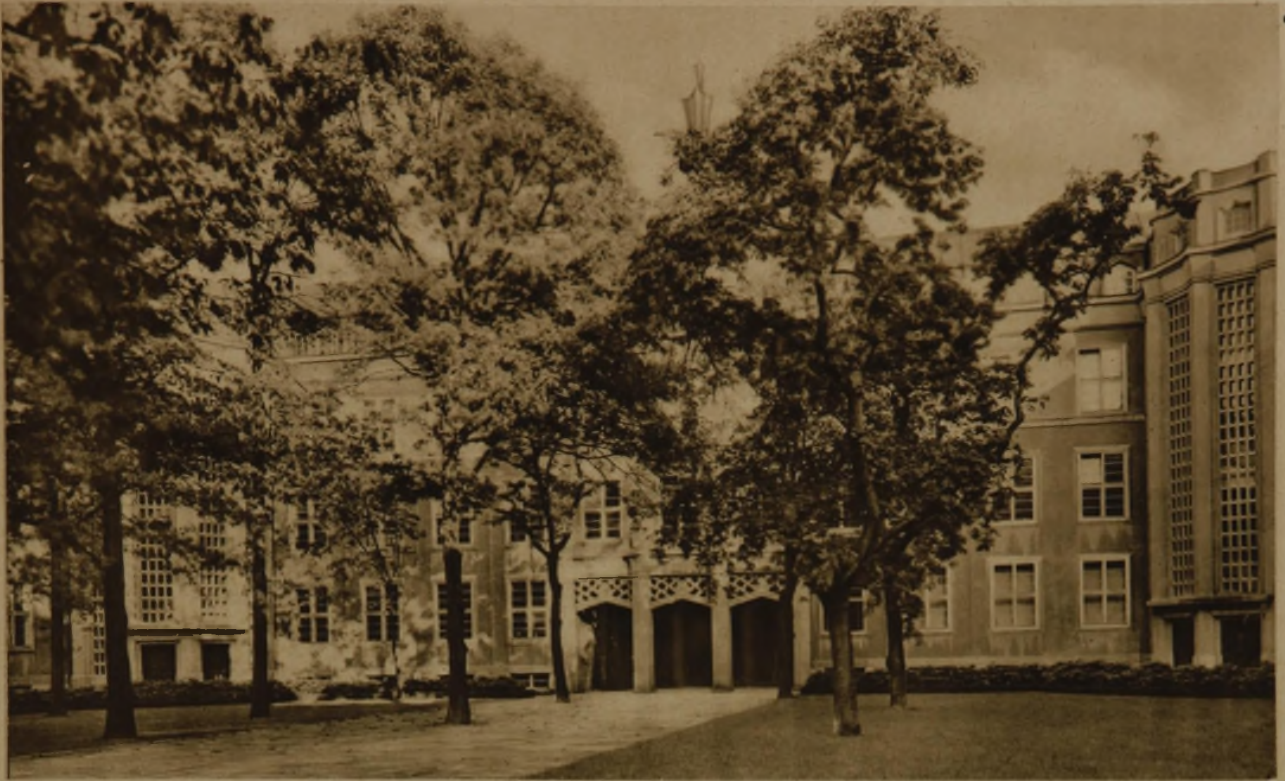
MITTELHOF, BLICK NACH OSTEN
