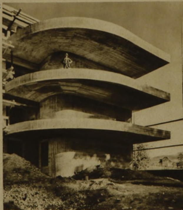
ROHBAU UND BEWEHRUNG DER EISENBETON-KRAGPLATTEN
