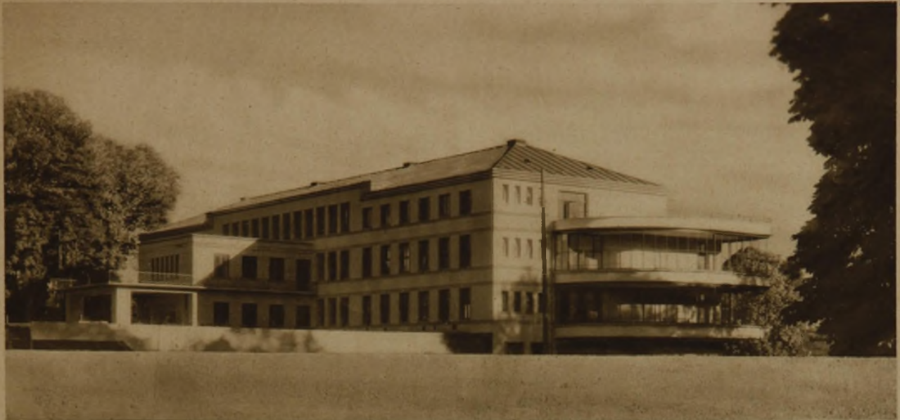
ANSICHT GEGEN NORDWESTEN MIT UNTERFAHRT UND LIEFERANTEN-EINGANG
