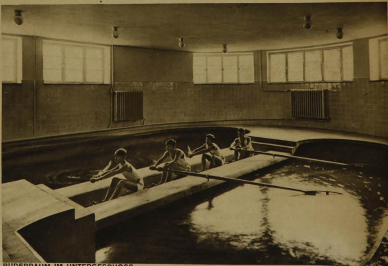
RUDERRAUM IM UNTERGESCHOSS
