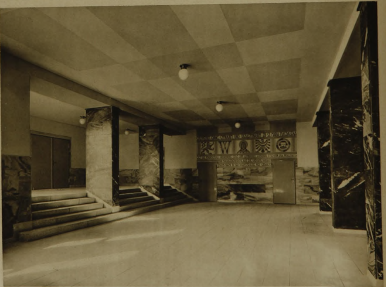
HALLE IM 1. OBERGESCHOSS VOR DER AULA
