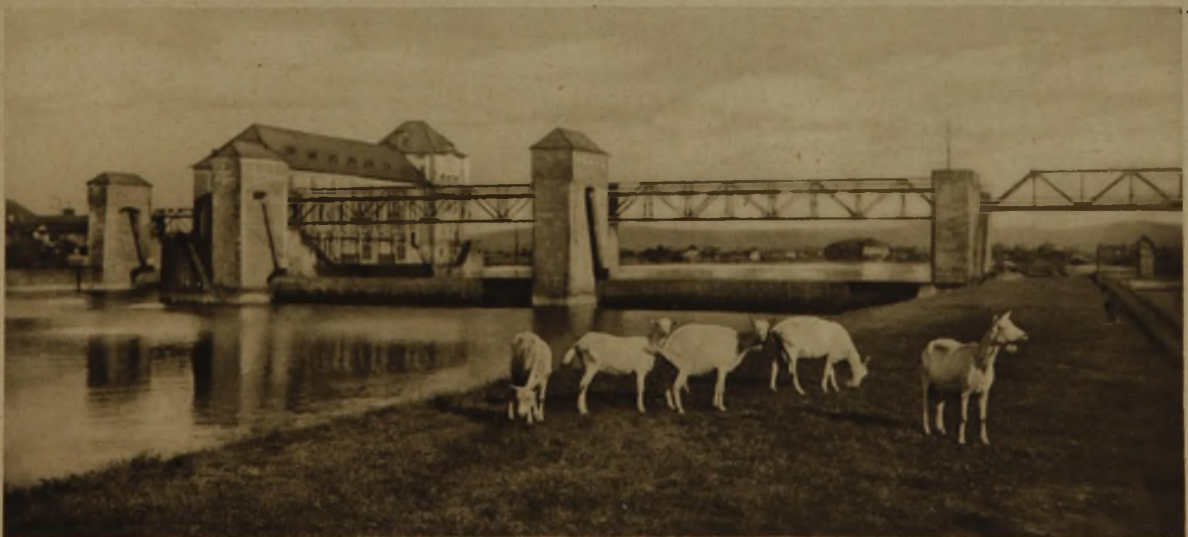
BLICK VOM LINKEN MAINUFER VON UNTERHALB
