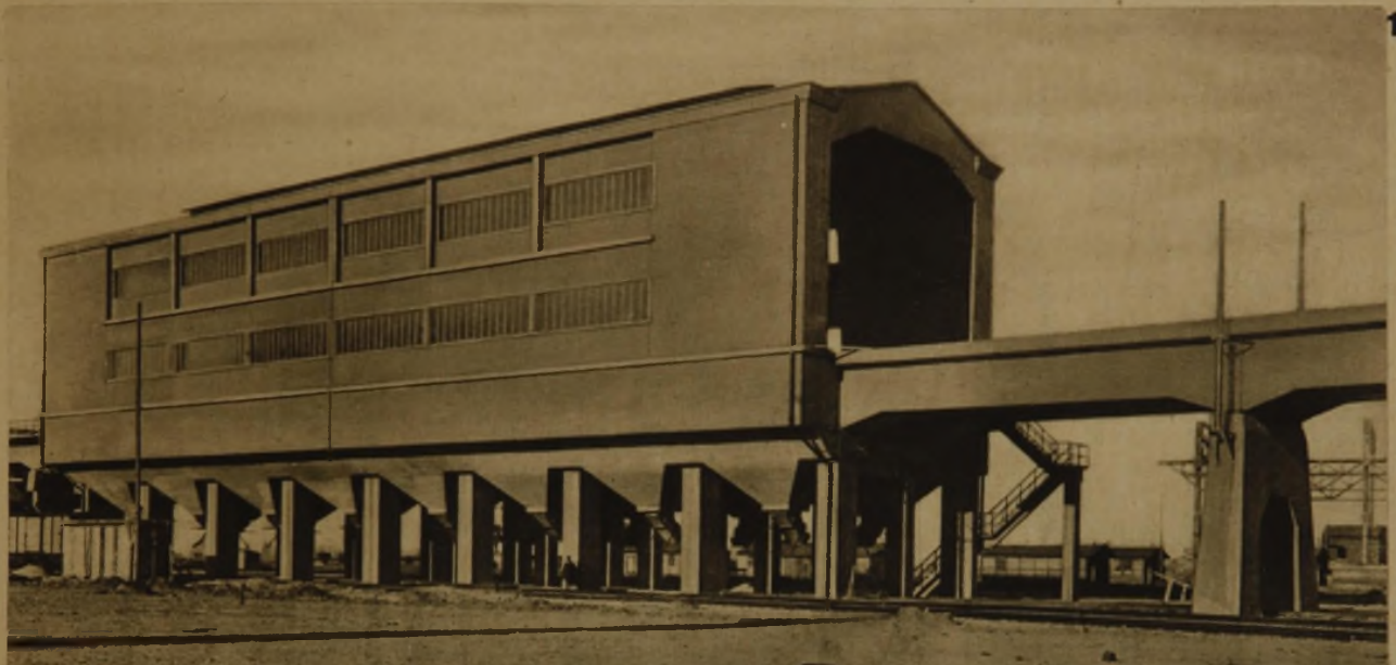
HOCHOFENWERK HUCKINGEN (MANNESMANNRÖHREN A.-G.). KALKBUNKER 15 m BREIT Ganz materialgemäß und dabei ästhetisch vorzüglich gelöst
