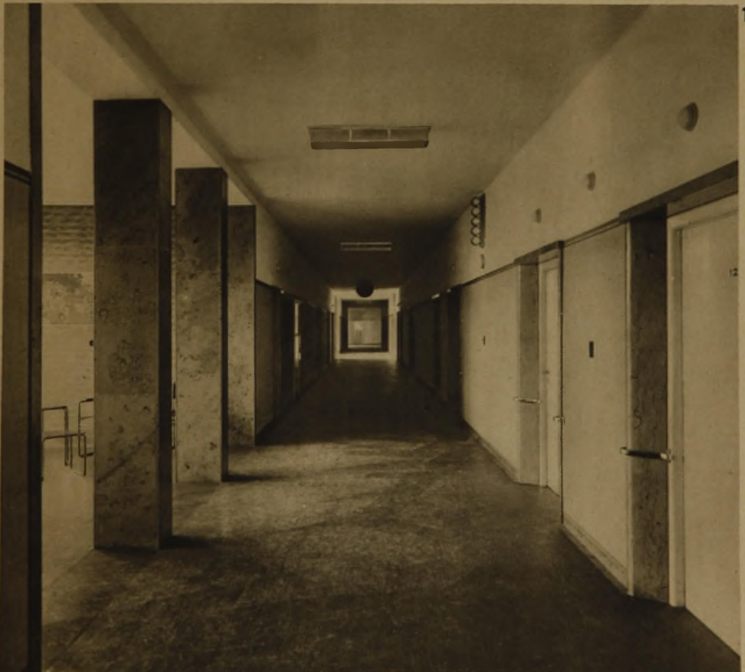
GANG MIT AUFENTHALTS- RAUM
