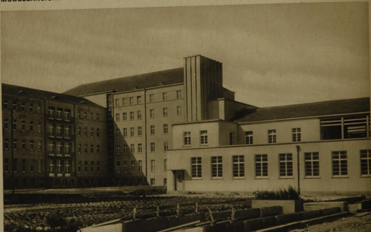
NORDOSTSEITE, RECHTS HEIZBAU MIT WÄSCHEREI
