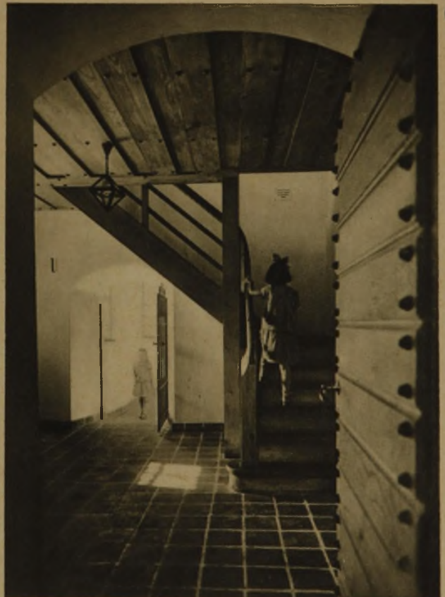
TREPPE IM TURM
