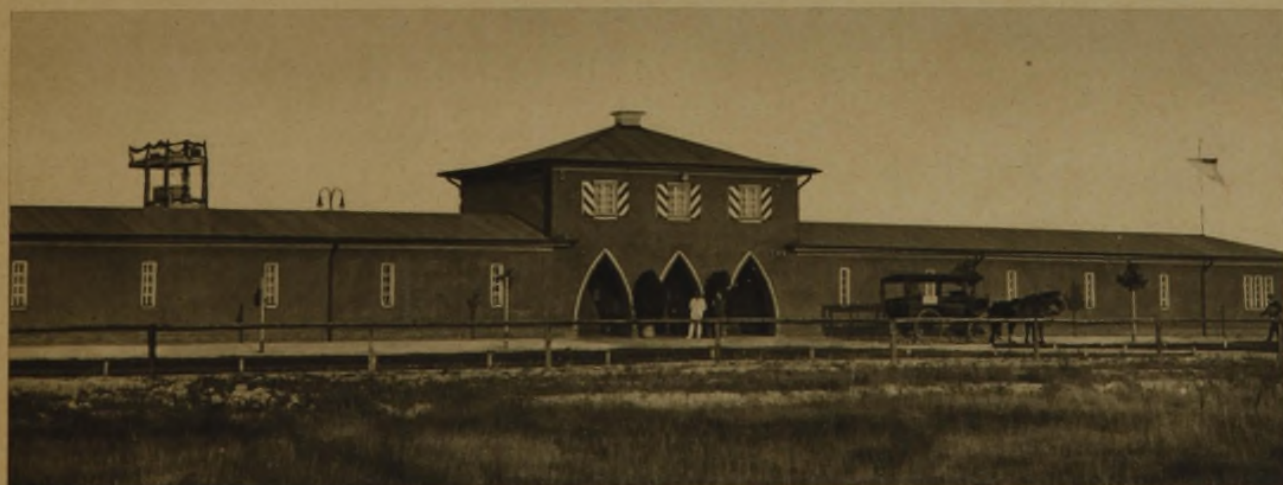
HAUPTGEBÄUDE MIT EINGANG UND BADEMEISTERWOHNUNG
