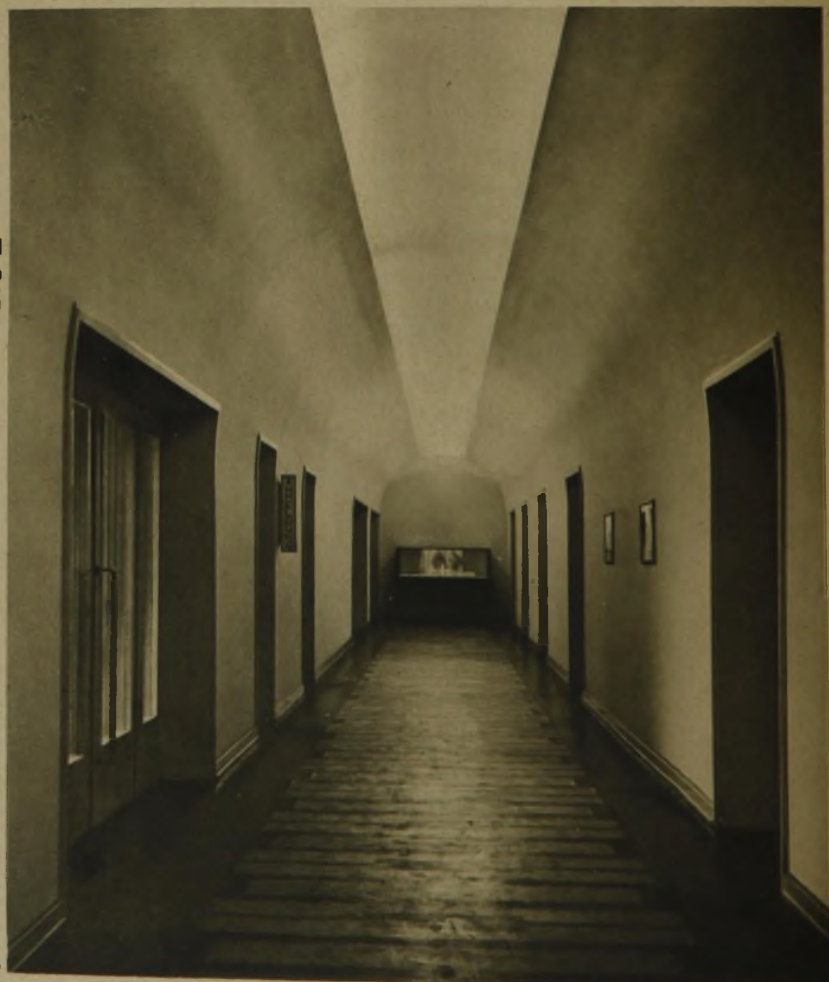
FLUR IM 1. OBERGESCHOSS
