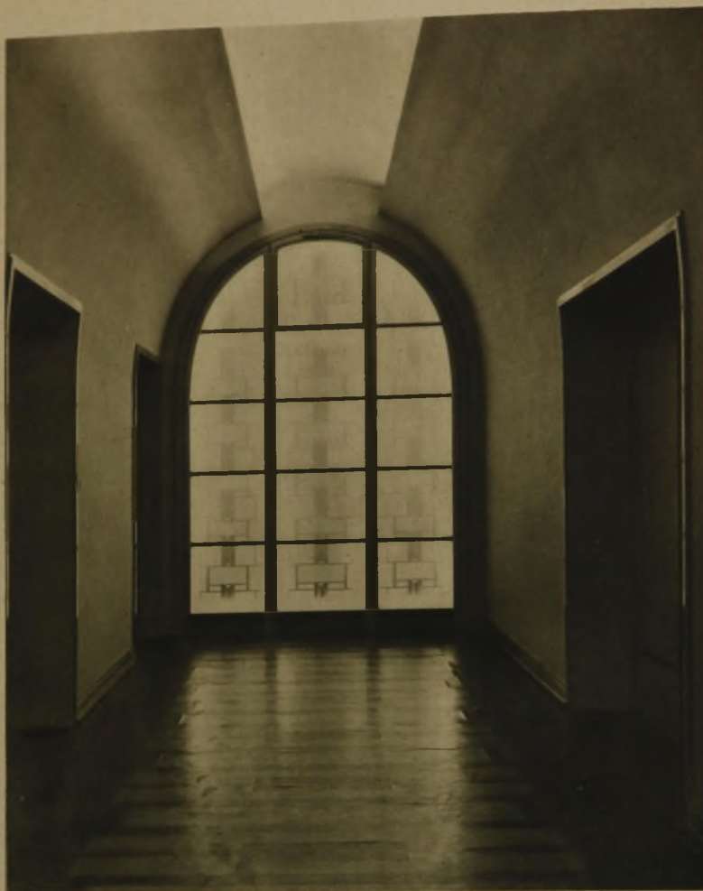
DAS VERWALTUNGSGEBÄUDE DER HAMBURGER ELEKTRIZITÄTSWERKE
