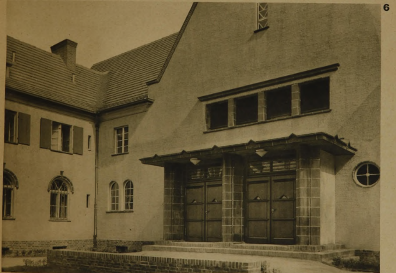
EINGÄNGE ZUM VERBINDUNGSBAU UND ZUM SAAL
