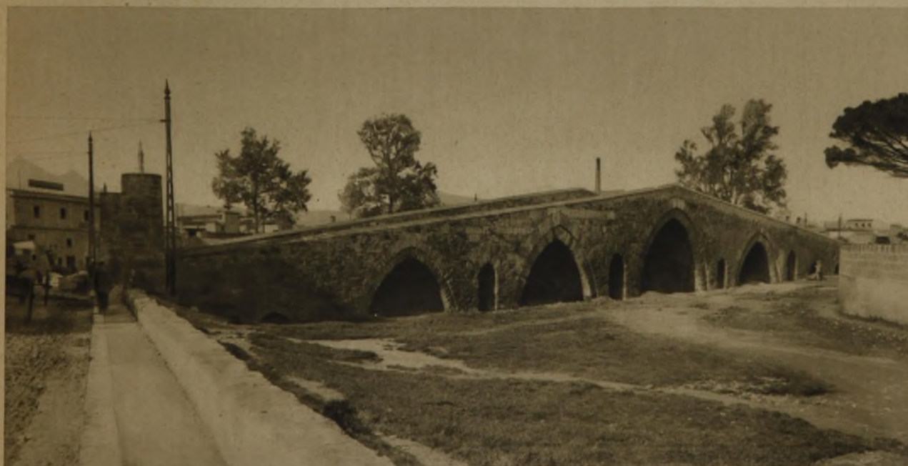
BRÜCKE AMIRAGLIO, PALERMO
