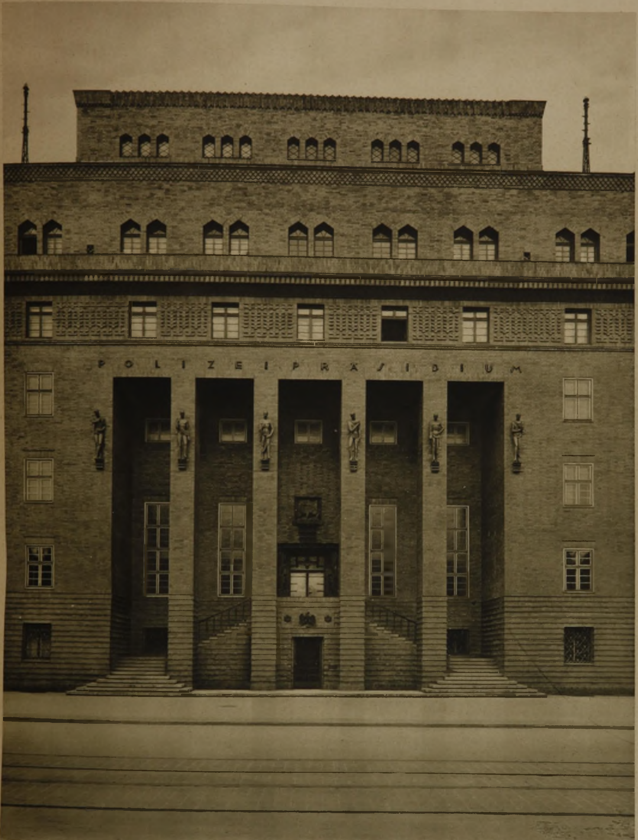
PLASTIK- UND SCHRIFTSCHMUCK IN SCHWARZER KLINKER-KERAMIK AUF KLINKER-VERBLENDERN AUSFÜHRUNG: GRUBE JLSE-BERGBAU-A.-G. HAUPTFASSADE DES POLIZEIPRÄSIDIUMS IN Breslau ARCHITEKT: BAURAT FERNHOLZ, PREUSSISCHES NEUBAUAMT Breslau
