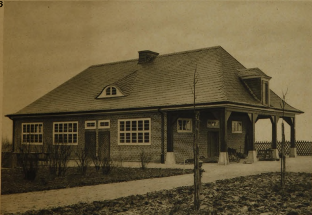
WERKSTATTGEBÄUDE MIT BESCHLAGRAUM
