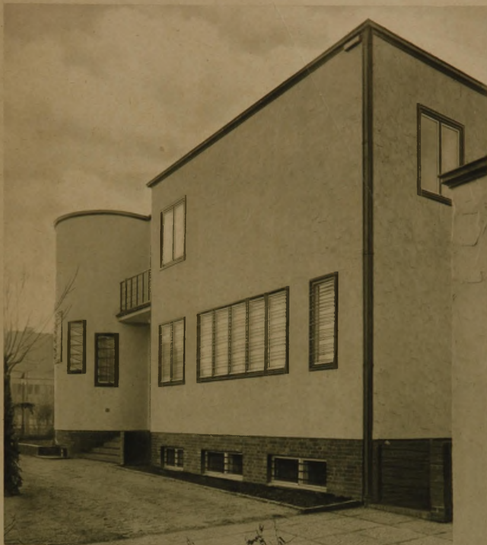
ANSICHT DES WIRTSCHAFTS- FLÜGELS MIT NEBENEINGANG
