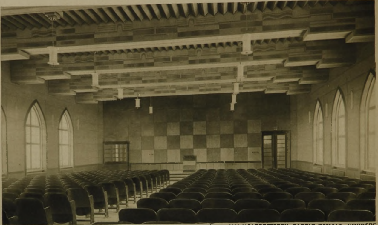
SCHULSAAL. DECKENFELDER ZWISCHEN DEN EISENBETONUNTERZÜGEN AUS HOLZBRETTTERN, FARBIG BEMALT. VORDERE WANDFLÄCHE MIT SPERRHOLZPLATTEN VERKLEIDET. DIE ÜBRIGEN WÄNDE MIT RUPFEN BESPANNT, FESTSTEHENDE KLAPPSESSEL; LINOLEUMFUSSBODEN
