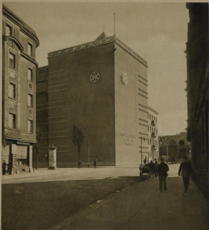
DER ECKBAU IM STRASSENZUGE
