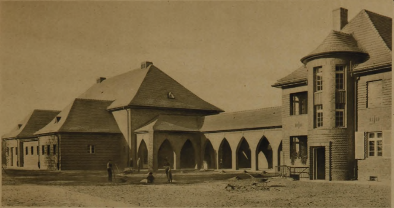
TURNHALLE UND WOHNGEBÄUDE DES HAUSMEISTERS VOM SCHULHOF AUS GESEHEN
