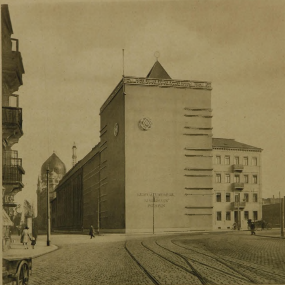
DER ECKBAU DER KRISTALLEISFABRIK MIT KÜHLHALLEN VOM PLATZ AUS
