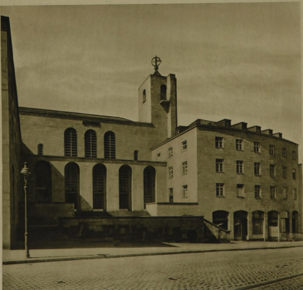
MITTELBAU MIT HAUPTPORTAL
