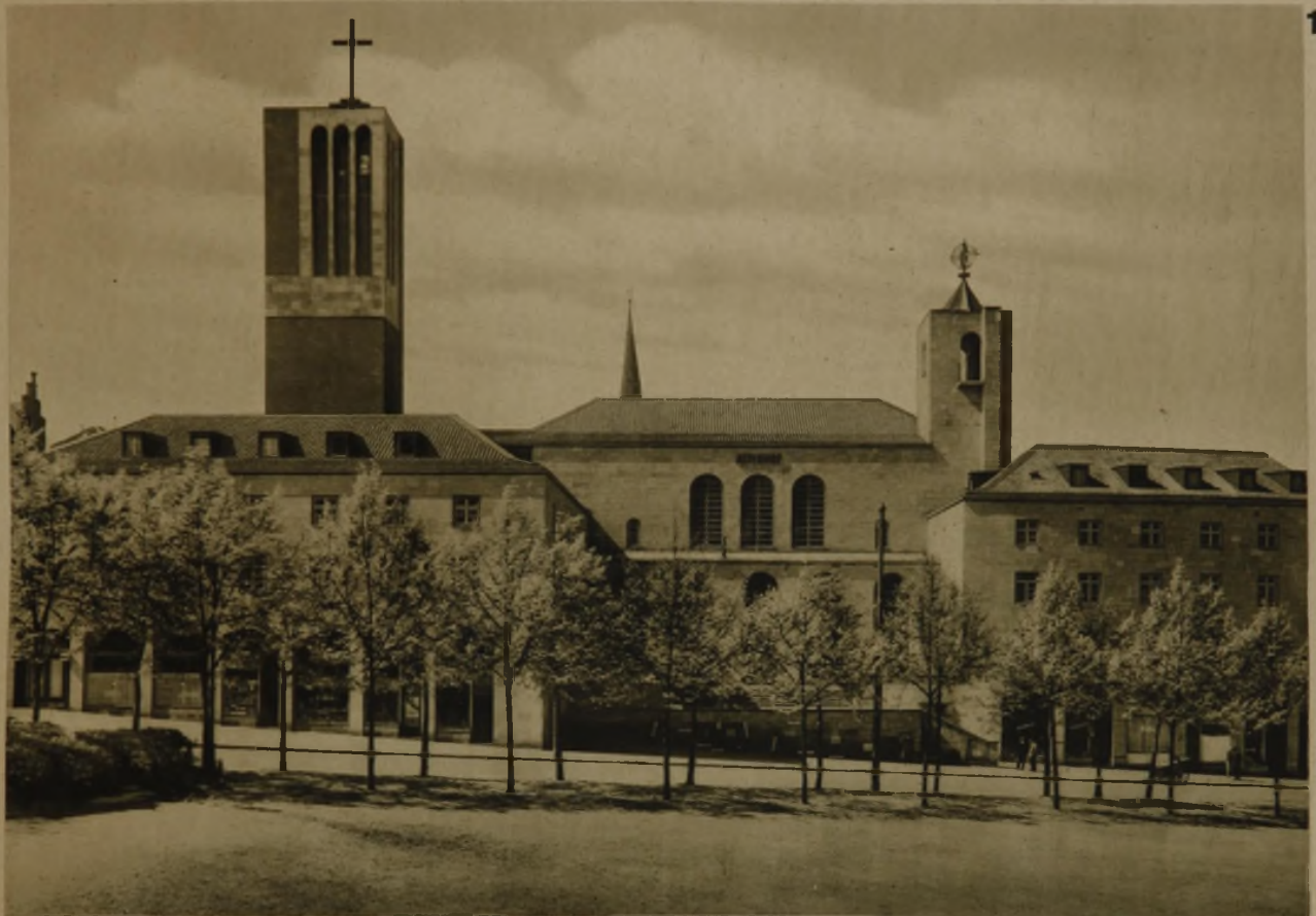
GESAMTANSICHT VOM KAISERPLATZ, IM HINTERGRUNDE TURM DER 1929 ERBAUTEN MARIENKIRCHE
