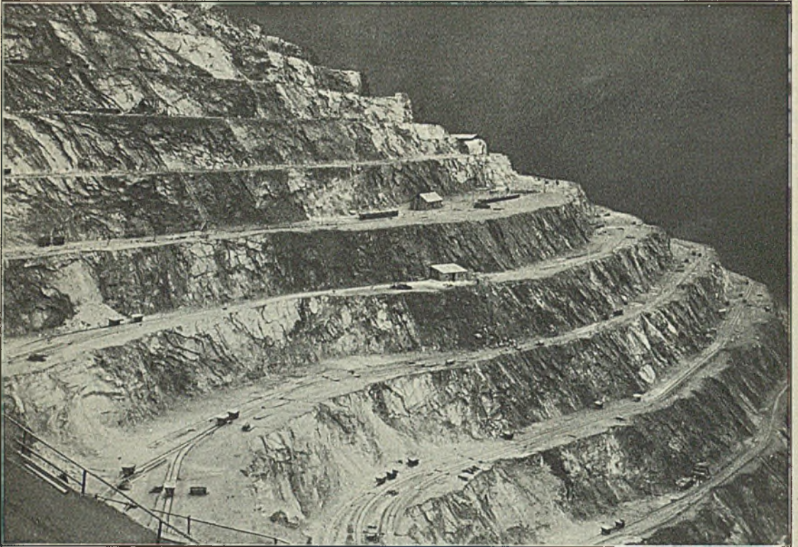
Abbildung 2. Etagenbau am Erzberg.
