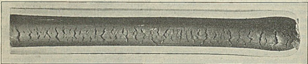
Abbildung 1. Rohrabschnitt mit Querrissen.
