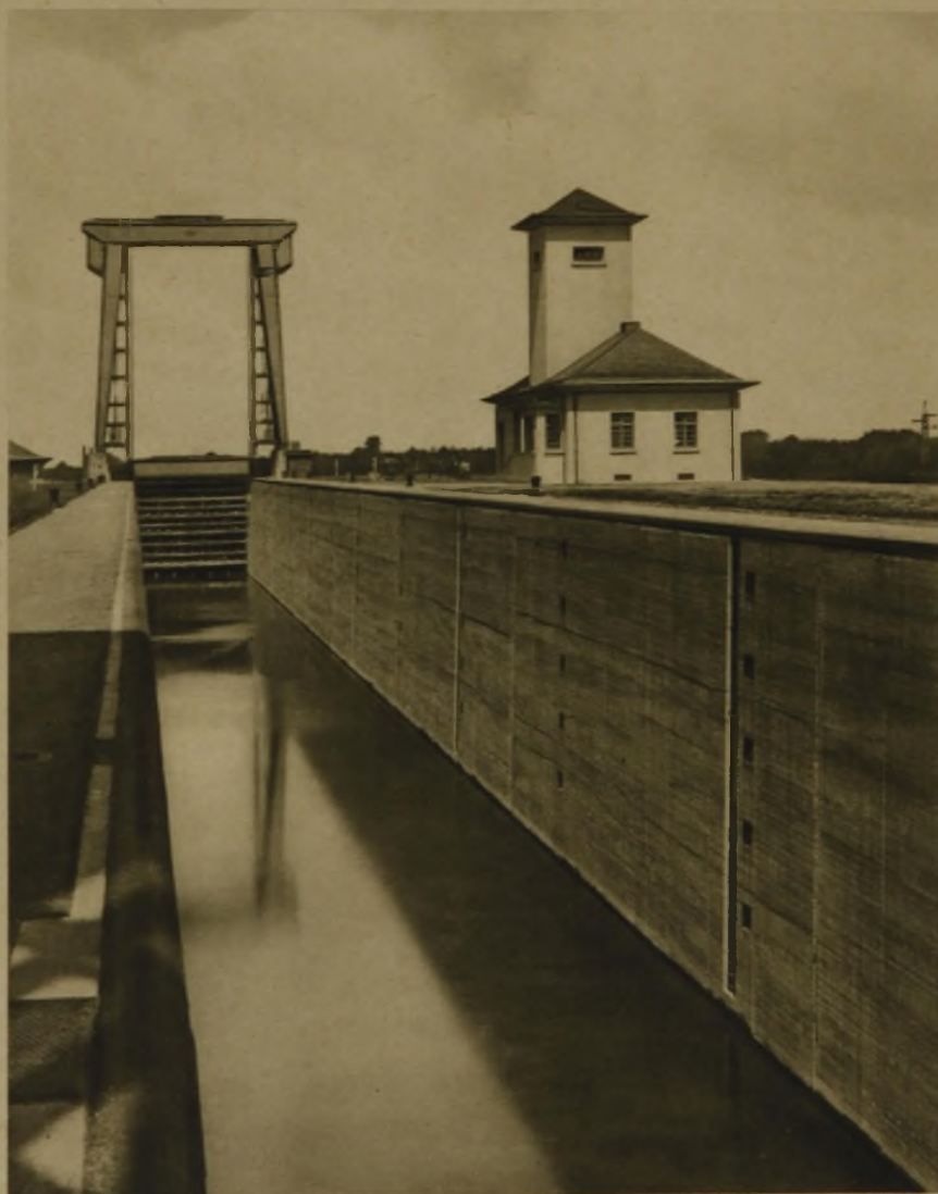
DIENTSGEBÄUDE UND SCHLEUSENKAMMER
