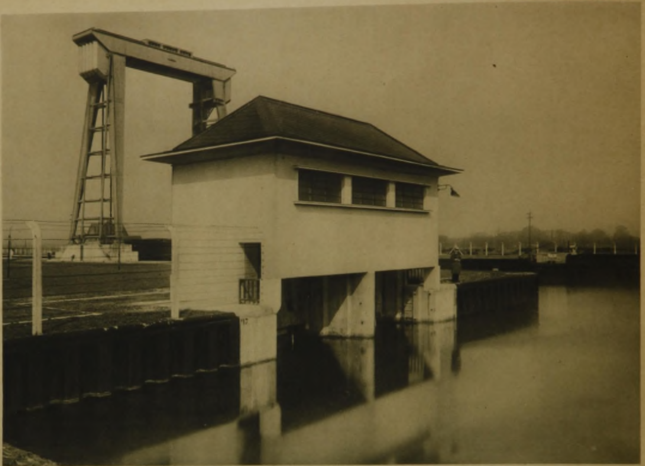
HOCHBAUTEN AM KANAL WESEL-DATTELN AUSLAUFWERK
