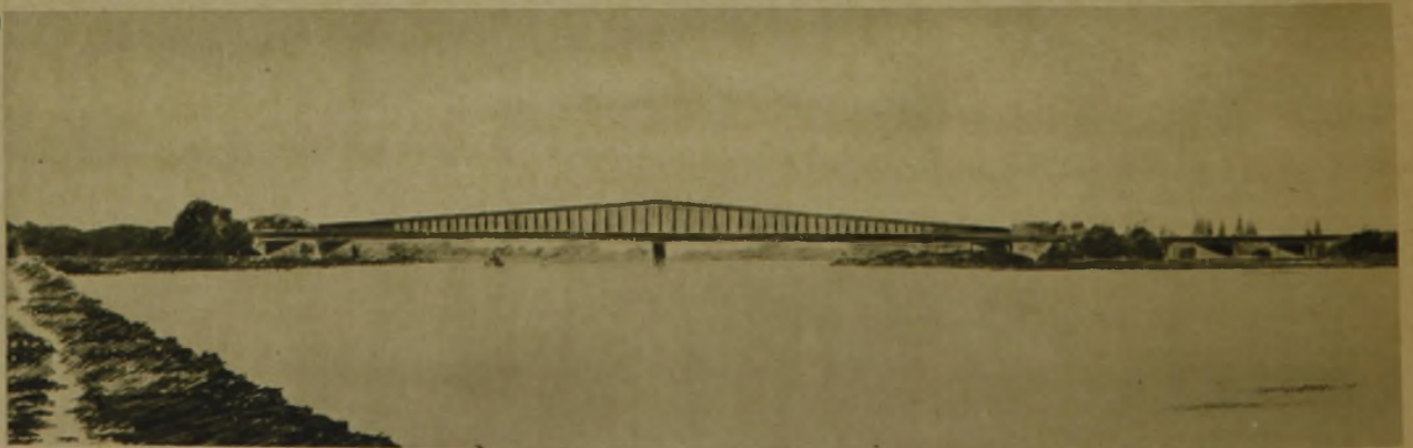
RHEINBRÜCKE SPEYER, MIT IN DER MITTE ABFALLENDEN RAHMENTRÄGERN
