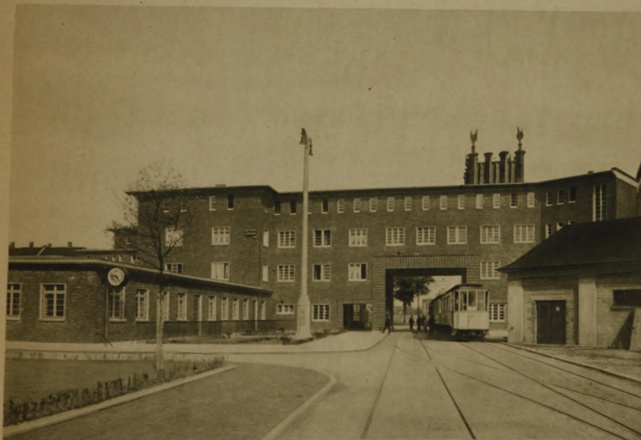
RÜCKSEITE DES BETRIEBSGEBÄUDES
