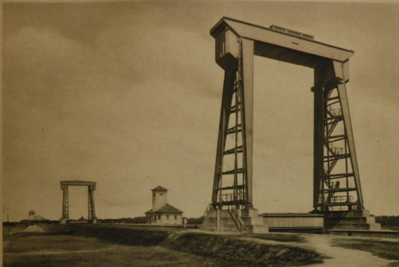
ABGABERHEBE- UND TRANSFORMATORENSTATION DATTELN
