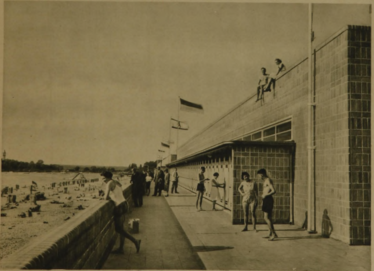
DAUERKABINEN AUF DER TERRASSE DER UMKLEIDEHALLEN
