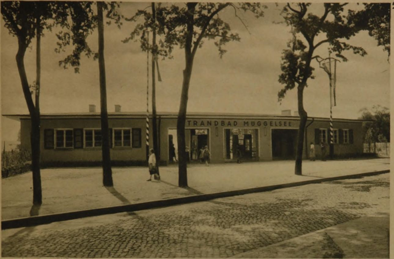
STRASSESEITE DES EINGANGSGEBÄUDES
