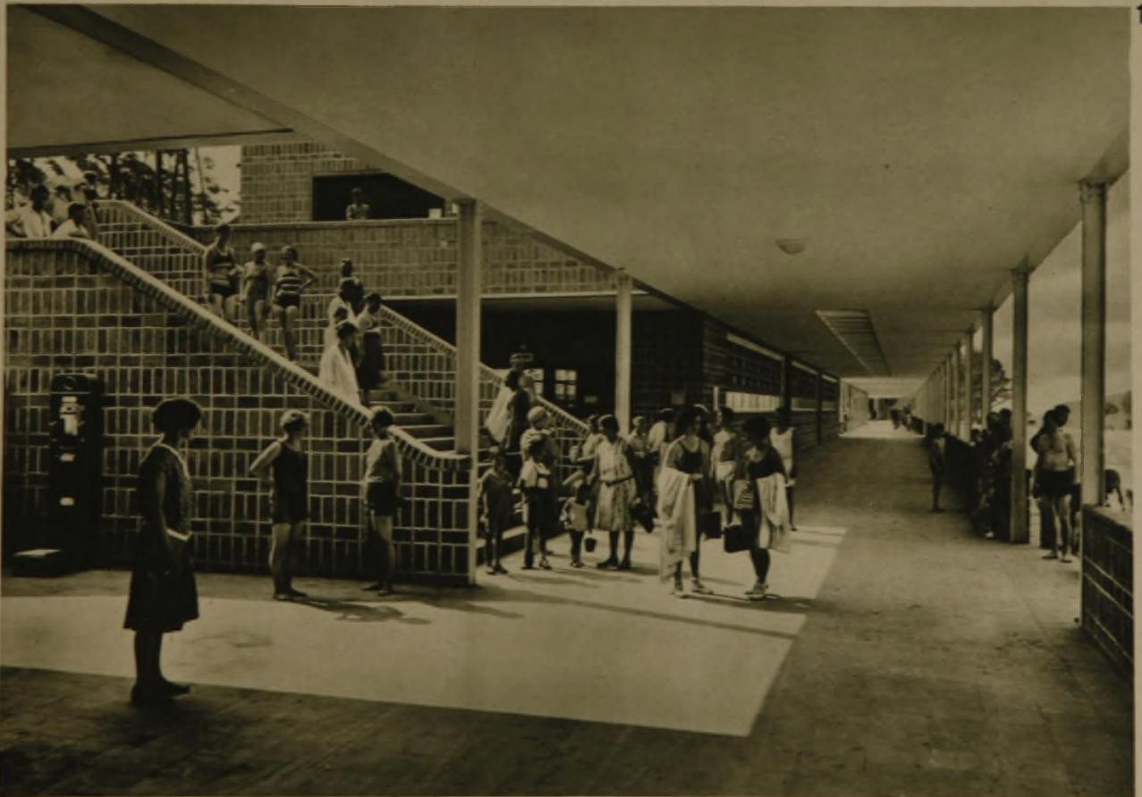
TREPPE ZU DER OBEREN TERRASSE NEBST WANDELGANG IM STRANDBAD WANNSEE
