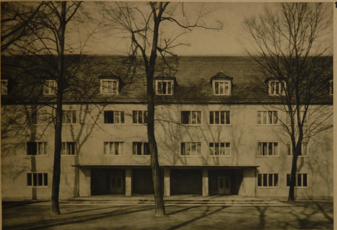
GARTENSEITE MIT BLICK AUF DIE LIEGEHALLE
