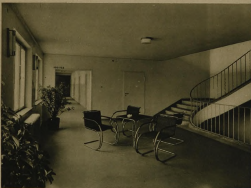
TREPPENHAUS UND FLUR IM ALTERSHEIM FUSSBODEN: HELLGRAUES LINOLEUM WÄNDE UND DECKE: WEISS
