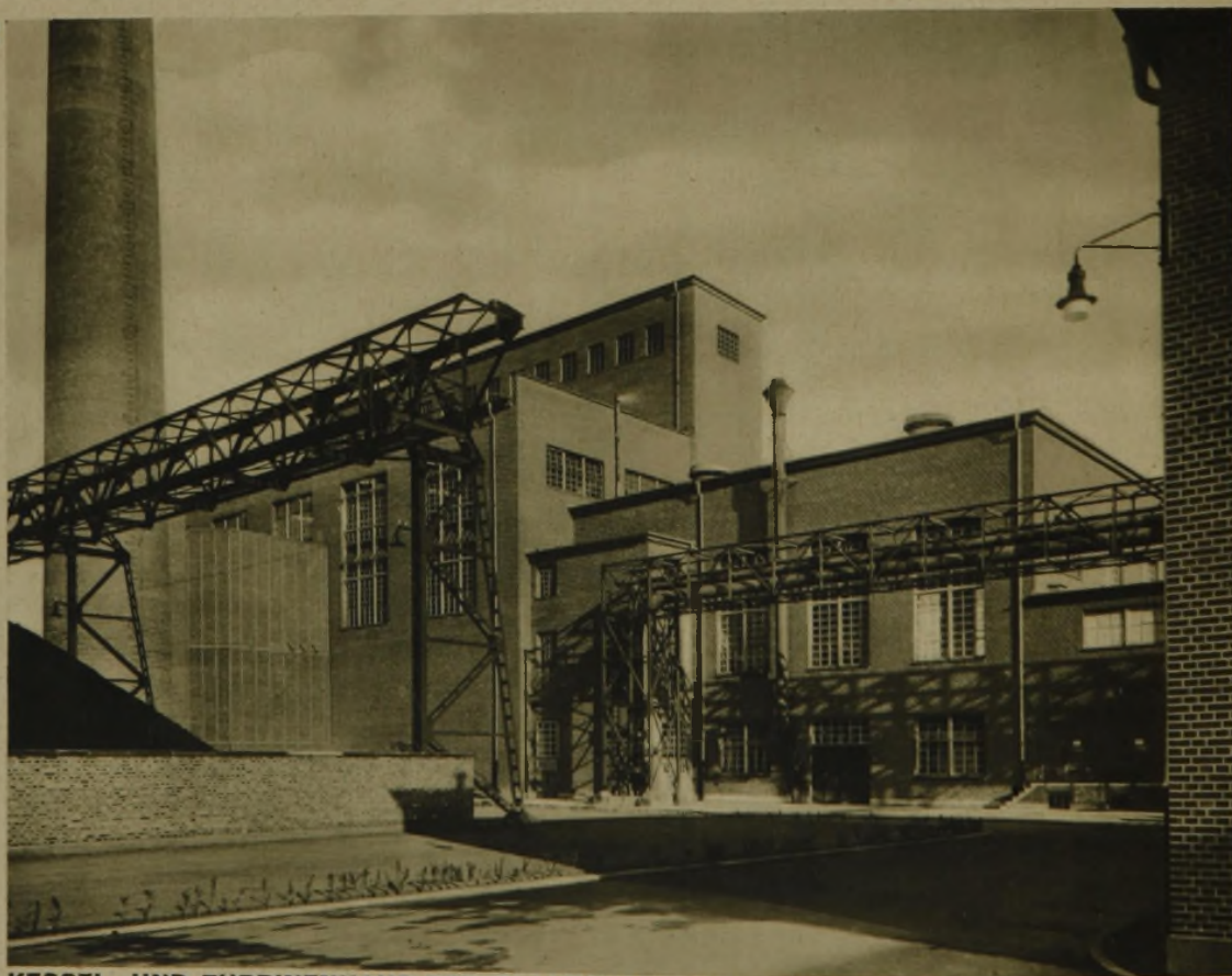
KESSEL- UND TURBINENHAUS DER GLANZSTOFF-COURTAULDS G. M. B. H.
