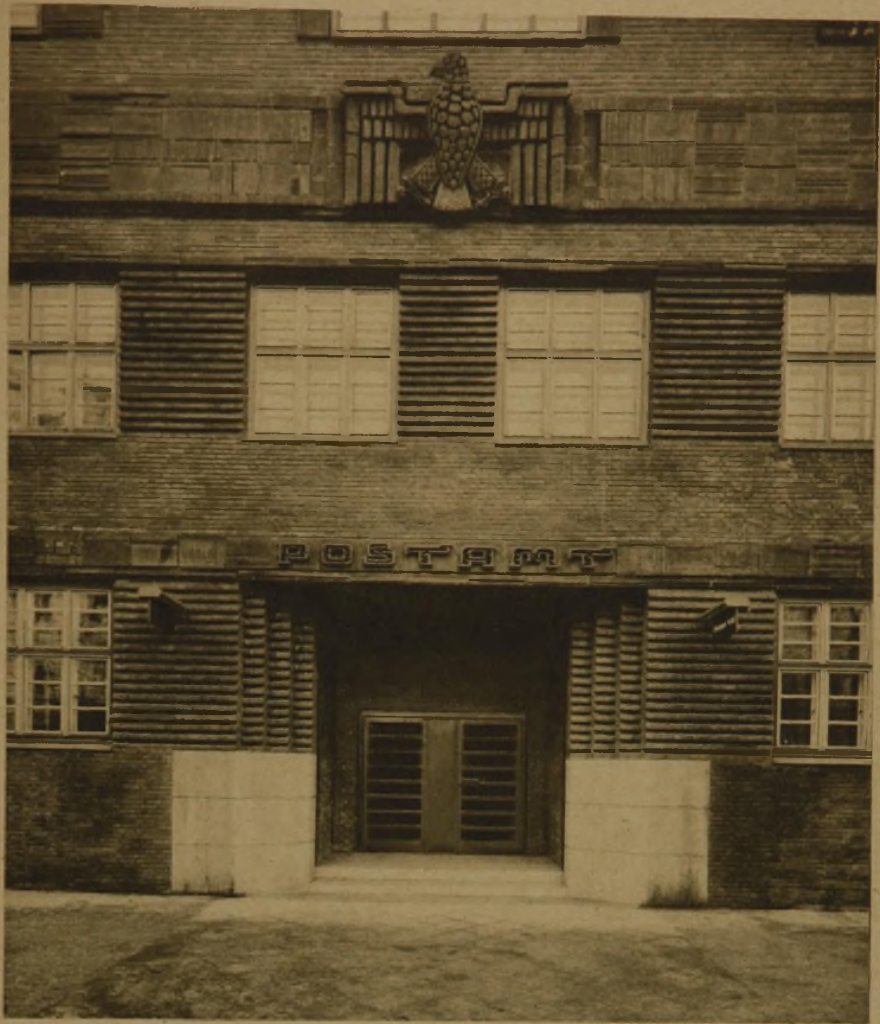
PORTAL DES POSTGEBÄUDES IN DER GERICHTSSTRASSE BERLIN ARCH. POSTBAURAT TIETZE, FENSTERGEWÄNDE, GESIMSE UND PLASTISCHER SCHMUCK VON PROF. REGER
