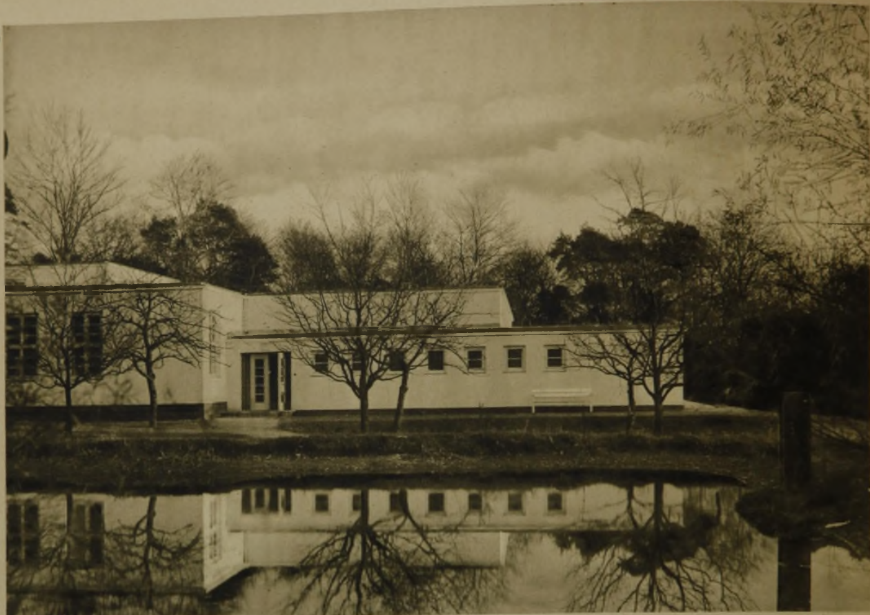
WALDSCHULE IN DRESDEN ARCHITEKT STADTBAURAT DR.-ING. E. H. PAUL WOLF, DRESDEN
