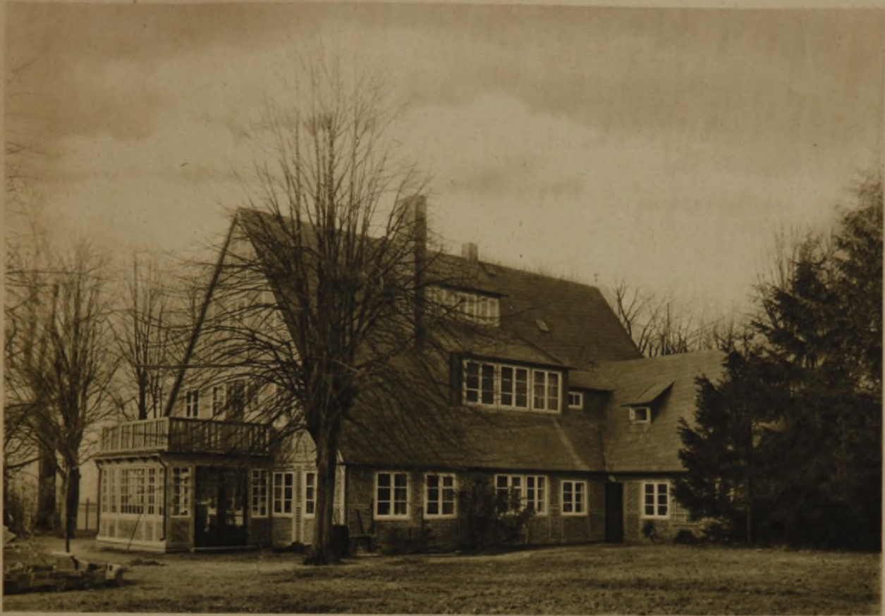
GESAMTANSICHT DES WOHNHAUSES IN OHLSTEDT BEI HAMBURG ARCHITEKT PROF. H. C. C. WACH, BERLIN
