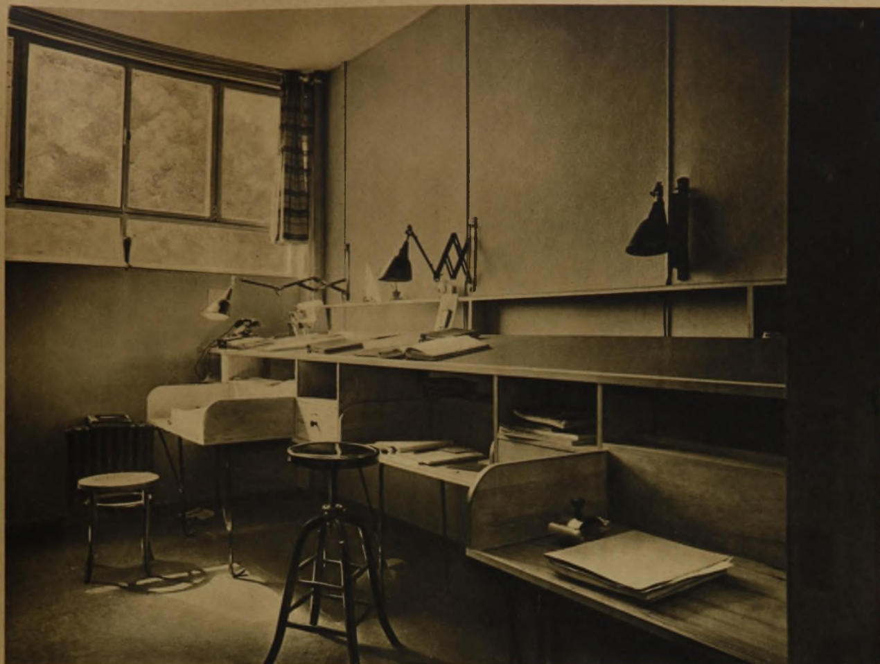
BLICK IN EINEN BÜRORAUM BÜRO- UND LAGERHAUS IN BRAUNSCHWEIG
