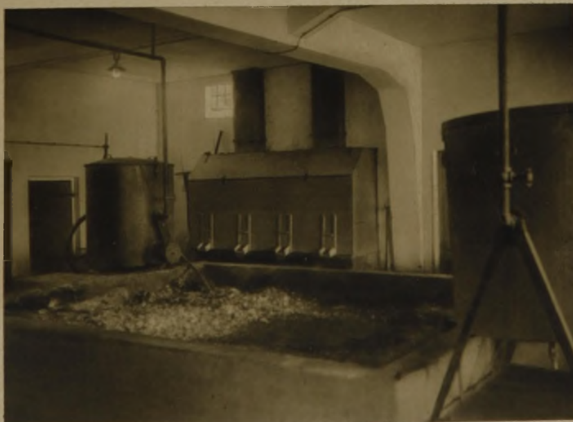
INNENANSICHT DER FUTTERKÜCHE MIT KRAFTFUTTER- ABWURFS- SCHÄCHTEN
