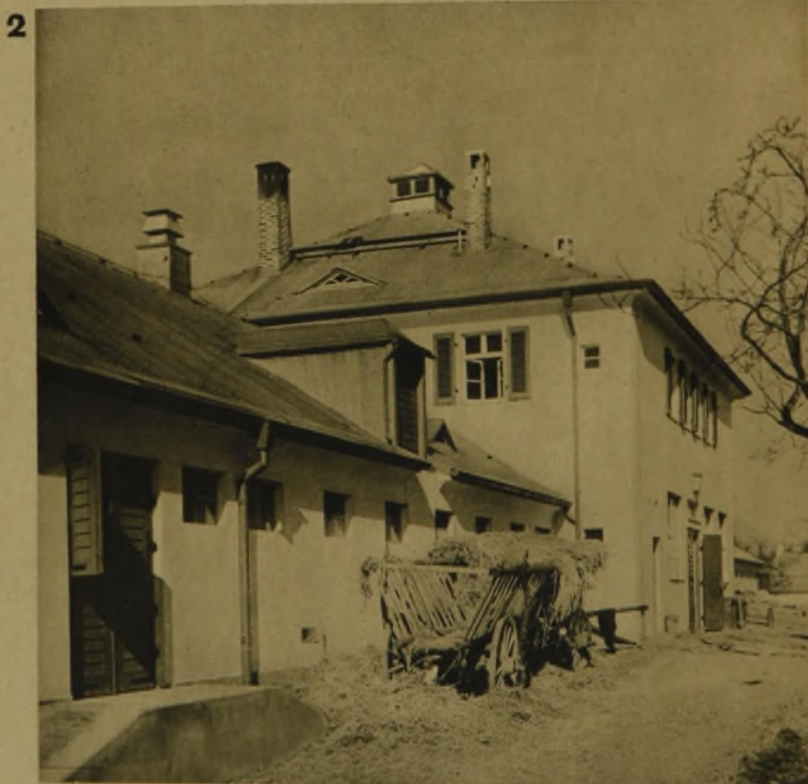
MITTELBAU UND MASTSTALL DES SCHWEINESTALLGEBÄUDES
