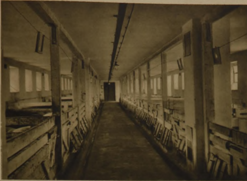
INNENANSICHT DES ZUCHTSTALLES
