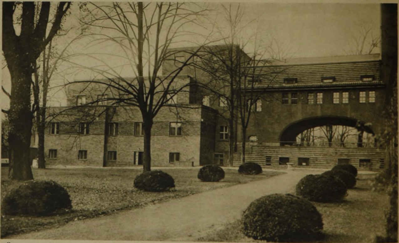
RÖNTGENHAUS IM KRANKENHAUS WESTEND, CHARLOTTENBURG ARCHITEKT BEZIRKSHOCHBAUAMT, CHARLOTTENBURG
