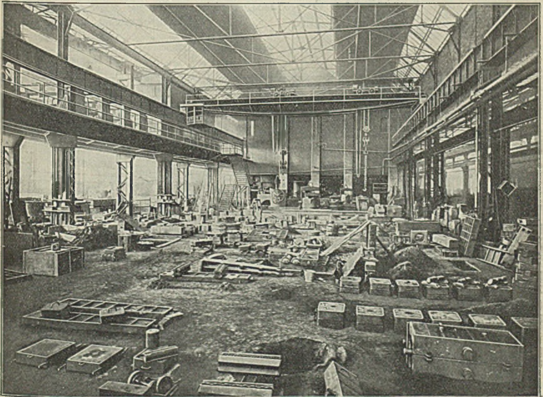
Abbildung 26. Halle mit 40-t-Laufkran und 2 Katzen von je 20 t Tragkraft, Thyssen & Co., Mülheim-Ruhr.
