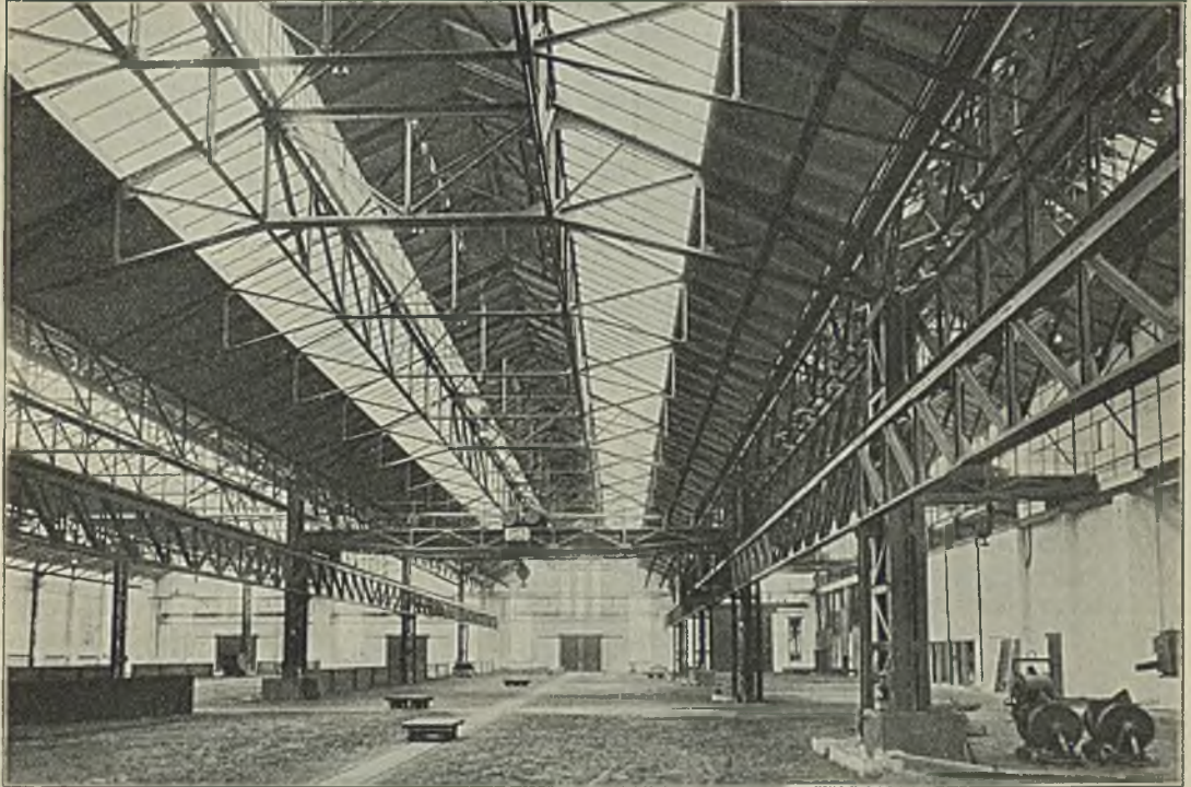
Abbildung 3. Gießereihalle vor der Inbetriebnahme.
