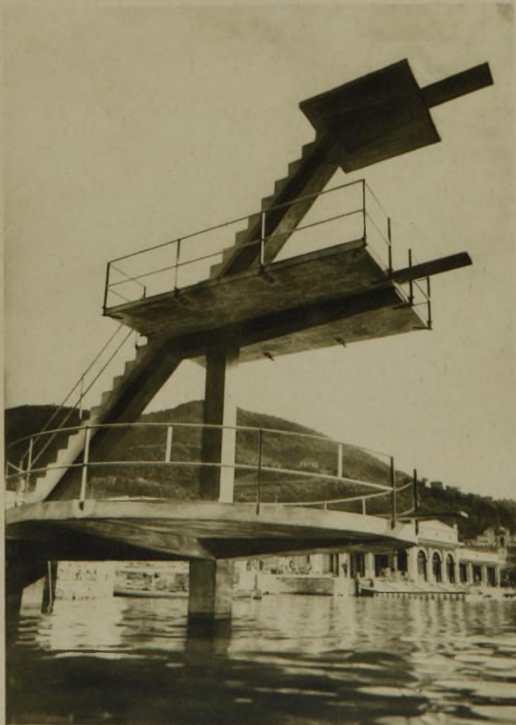
**Sprungturm aus Eisenbeton 19 m hoch
