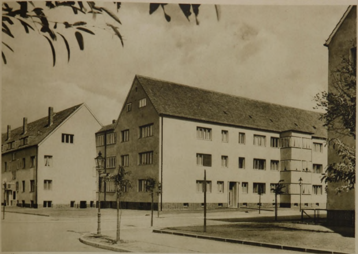
Siedlung Haderslebener Straße am Breitenbachplatz des B. W. V. Neukölln ARCHITEKTEN MEBES & EMMERICH, BERLIN
