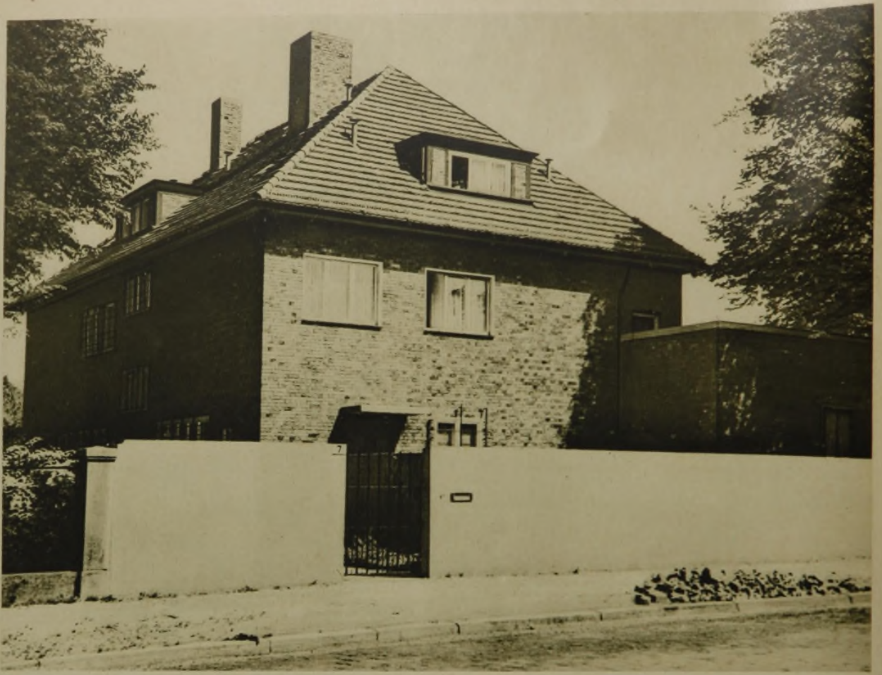
Haus A. Berlin-Zehlendorf. Straßenansicht
