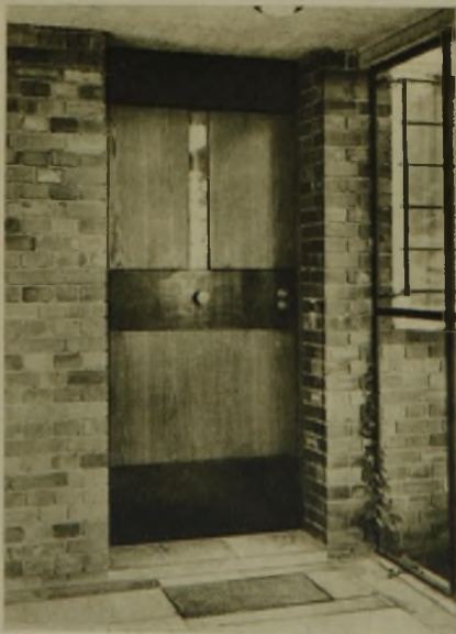
Haus A. Haupteingangstür
