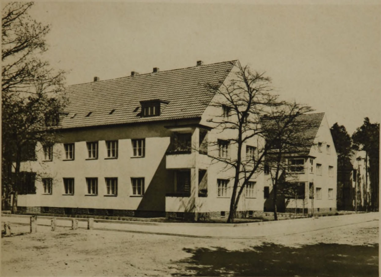
Siedlung Zehlendorf des B. W. V. Neukölln Bauteil III. Ecke Heinrichstraße
