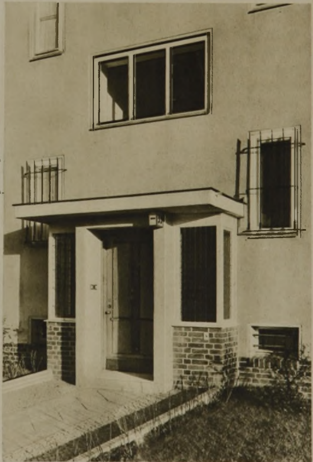
Portalansicht der Gruppen in der Haderslebener Straße
