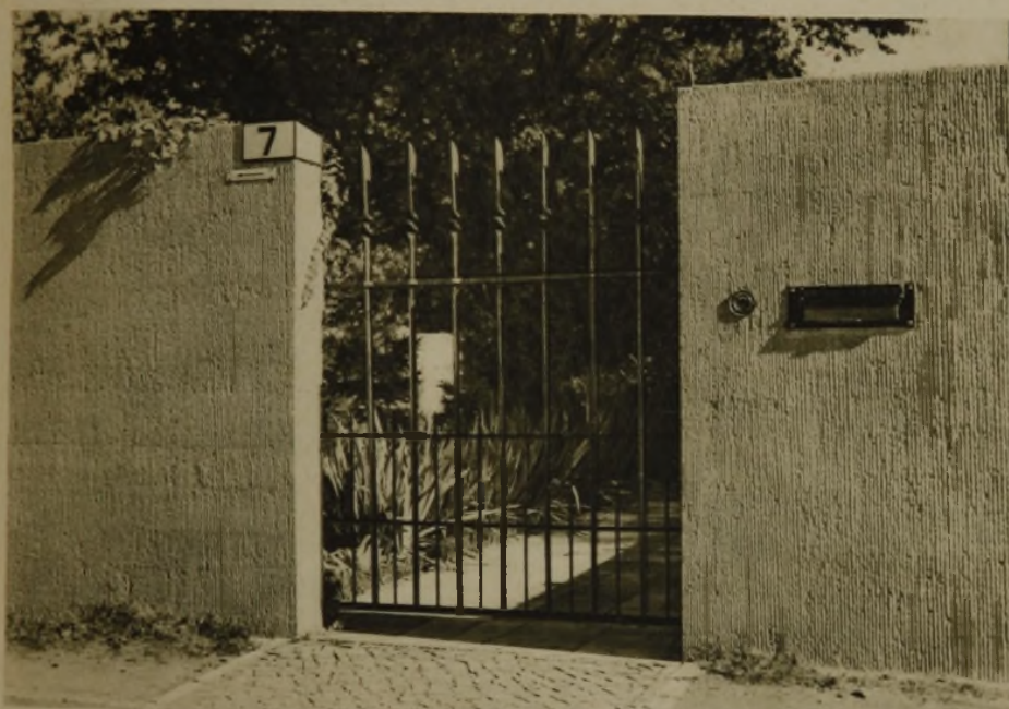
Haus A. Berlin-Zehlendorf Haupteingang an der Straße Tor geschmiedet von Prof. Prütz, Hannover
