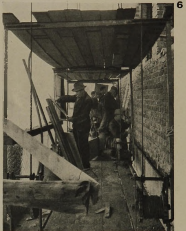
Blick in das Gerüst
