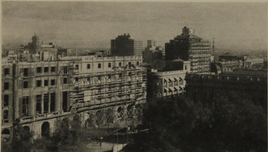
Hochhäuser über den quadratischen Baublöcken der City
