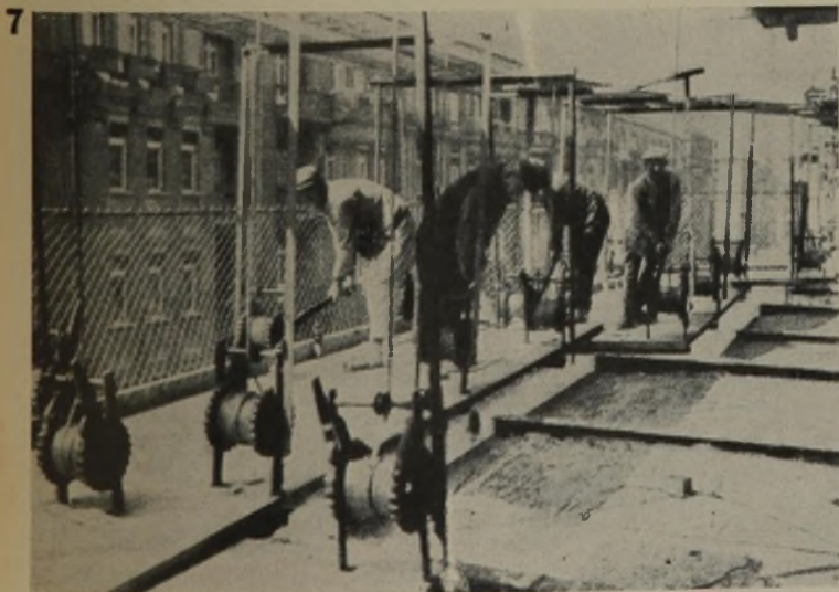
Blick vom Inneren des Baues auf die Rüstung
