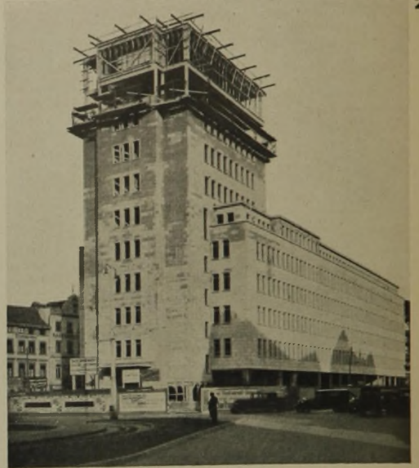
Haus Grenzacht in Aachen Stahl-Skelettbau
