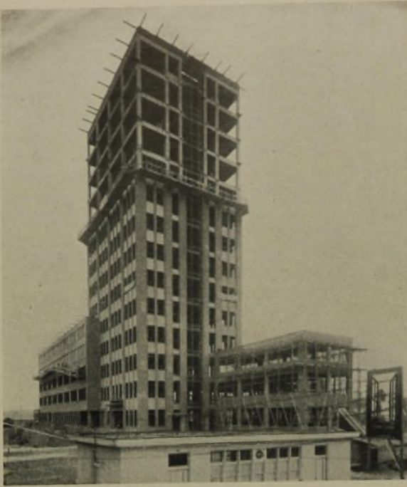
Kontorhaus in Rotterdam Eisenbeton-Skelettbau
