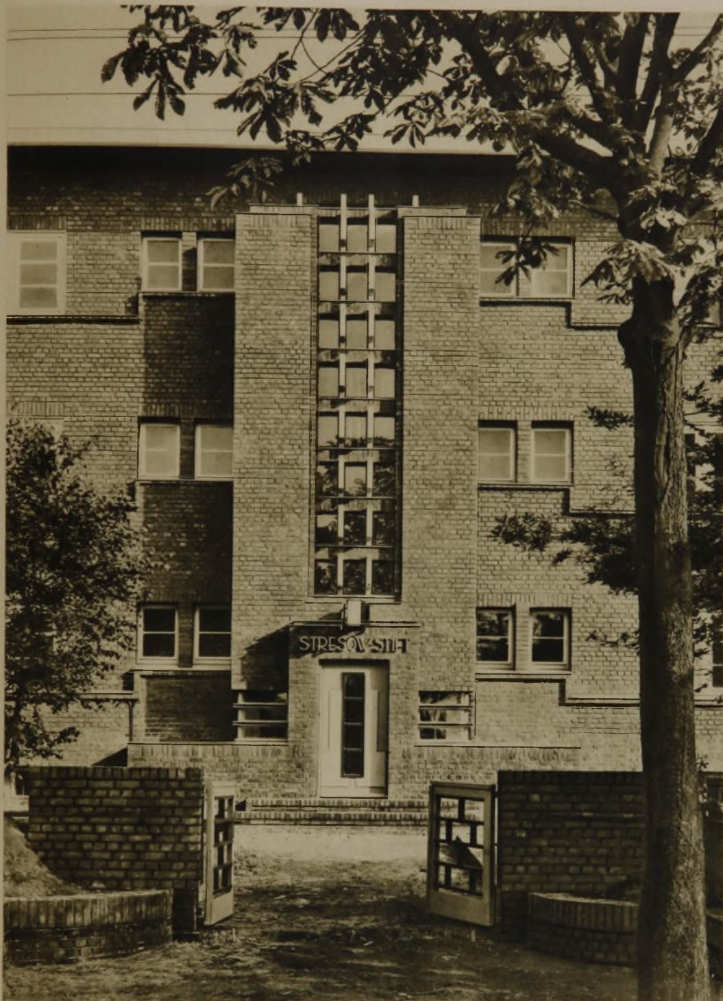
Teil der Straßenfront mit Haupteingang
