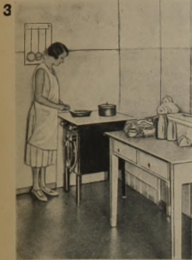
3 Vollelektrische Küche. Siedlung „Heimat“, Berlin - Siemensstadt (2-Platten-Herd und Bratröhre, 2750 Watt Aufnahme)
