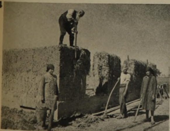
Abstechen der Wände durch den Wellermeister
