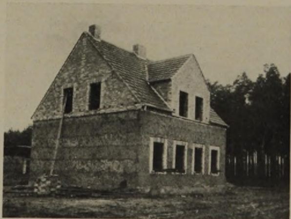
Fertiger Rohbau mit gemauerten Giebeln u. Fenster-Leibungen
