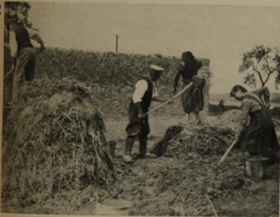
Mischen des Lehms mit Heidekraut oder Roggenstroh sowie Durchkneten
