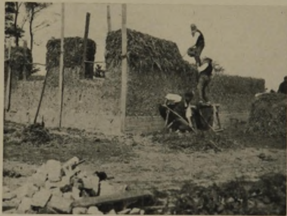
Aufpatschen des Lehms durch den Wellermeister Sicherung der Hausecken
