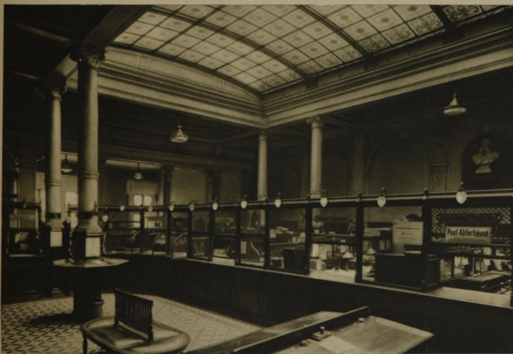
Kassenraum vor dem Umbau
