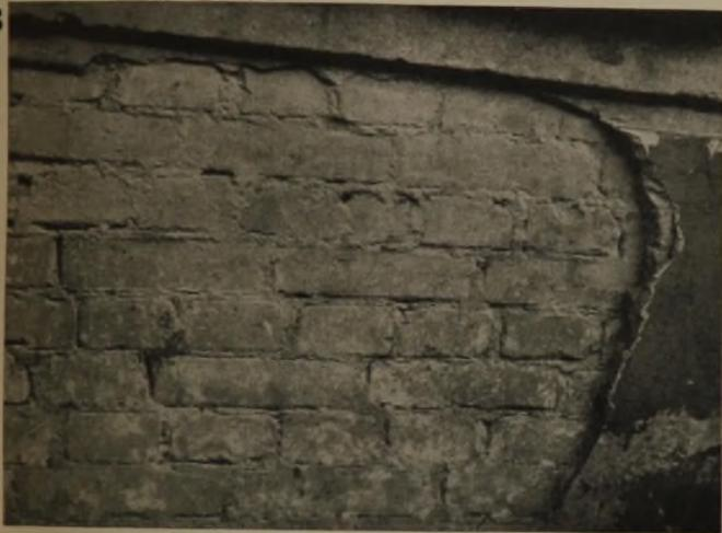
Mauerwerk mit vollen Fugen. Putz daher abgefallen
