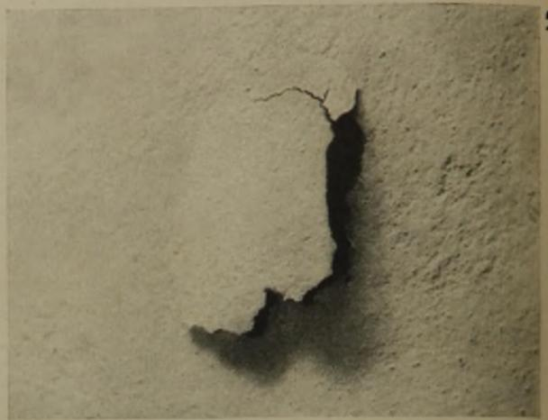
**Durch Sprengwirkung wird ein Stück Putzmörtel abgehoben**
