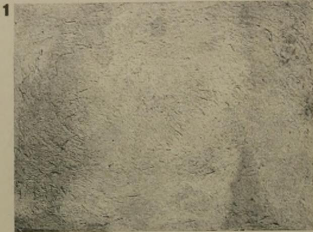
**Fleckenbildung durch Zusatz von Soda als Frostschutzmittel**
