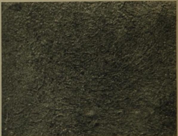
**Feinkörnig verriebene Oberfläche. Der handwerkliche Vorgang hat die Fläche linear gegliedert, ohne im Einzelnen aufdringliche Spuren zu hinterlassen**
