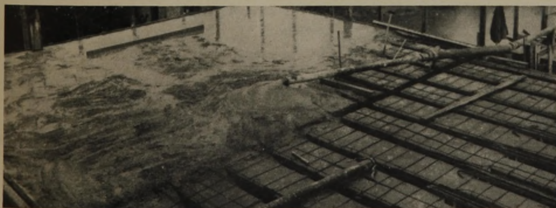
Betontransport durch Torkretpumpe bei der Pohlmann-Decke
