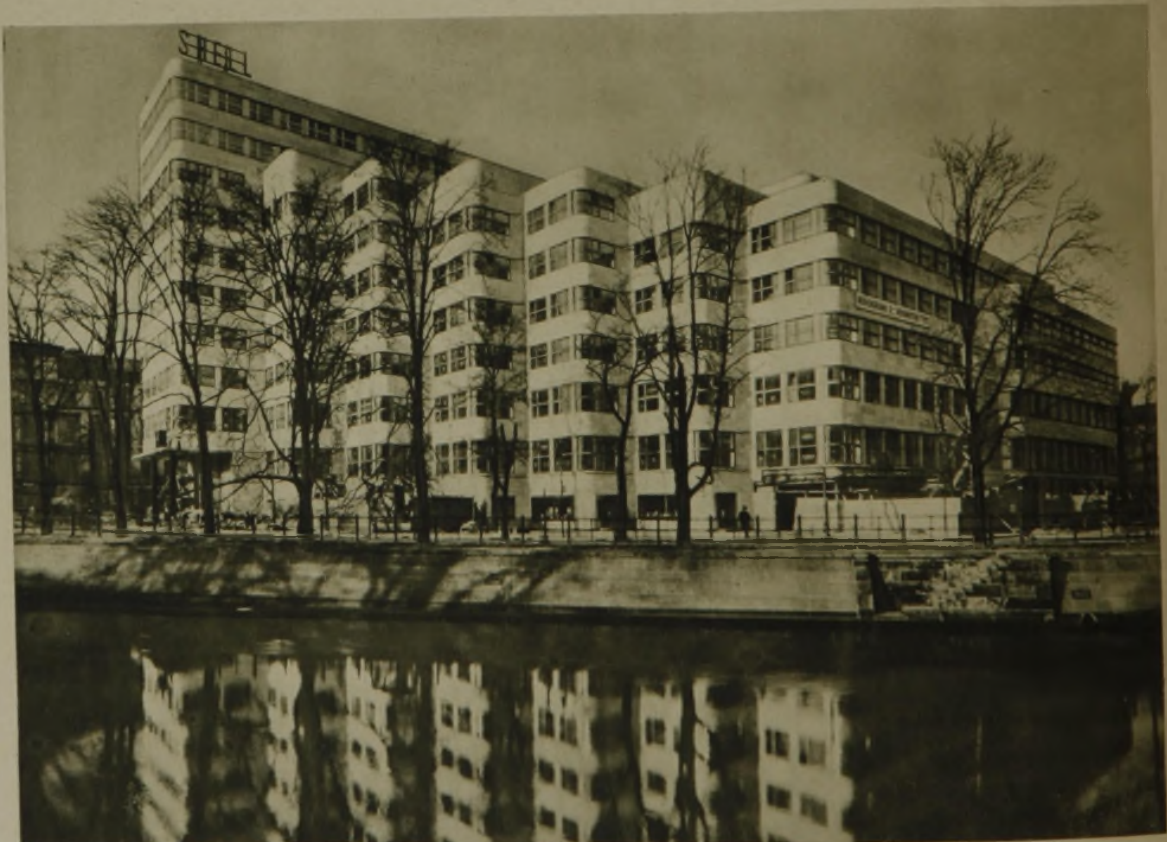
Verwaltungsgebäude Rhenania-Ossag, Berlin. ARCH. PROF. FAHRENKAMP, DÜSSELDORF
