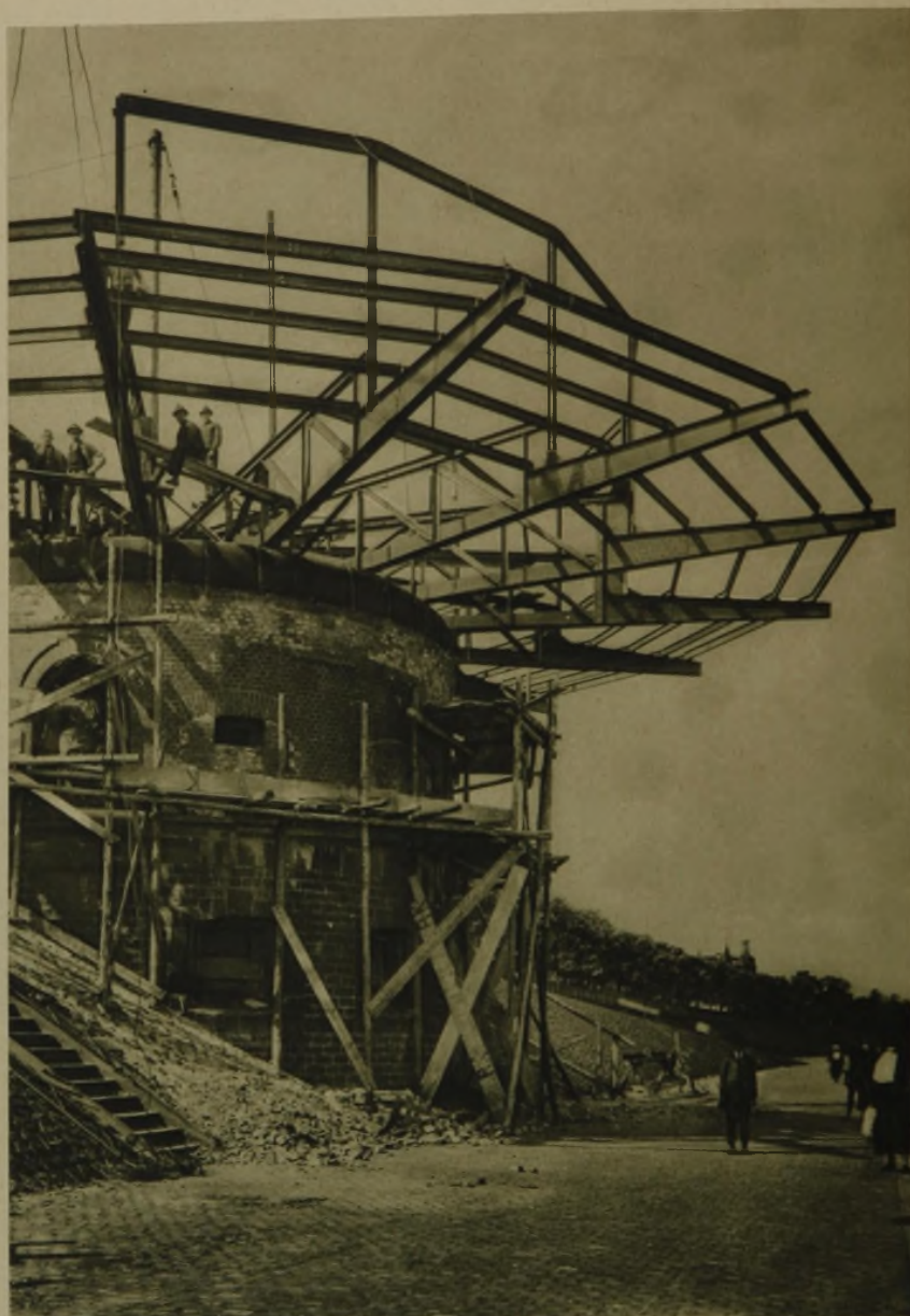
Weinrestaurant „Die Bastei“, Köln. Stahlskelett
