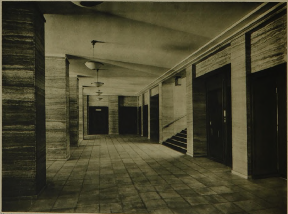
Vorhalle im Mittelbau Wände polierter römischer Travertin, Fußboden Solhofer Platten
