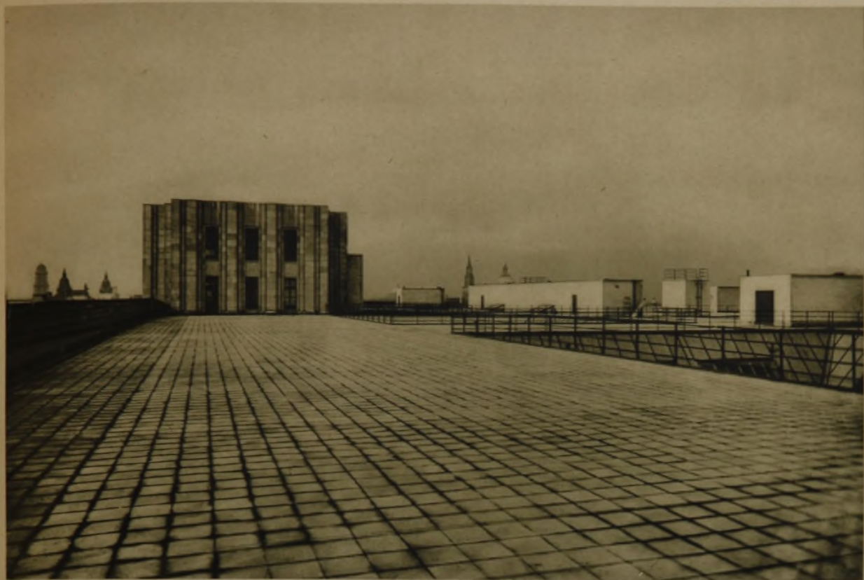
Dachterrasse in 32m Höhe mit den beiden Turmgeschossen Fußboden hydraulisch gepreßte Kunststeinplatten
