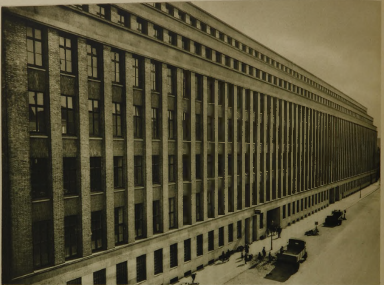
Front in der Keibelstraße Oldenburger Klinker mit Ettringer Tuffstein
