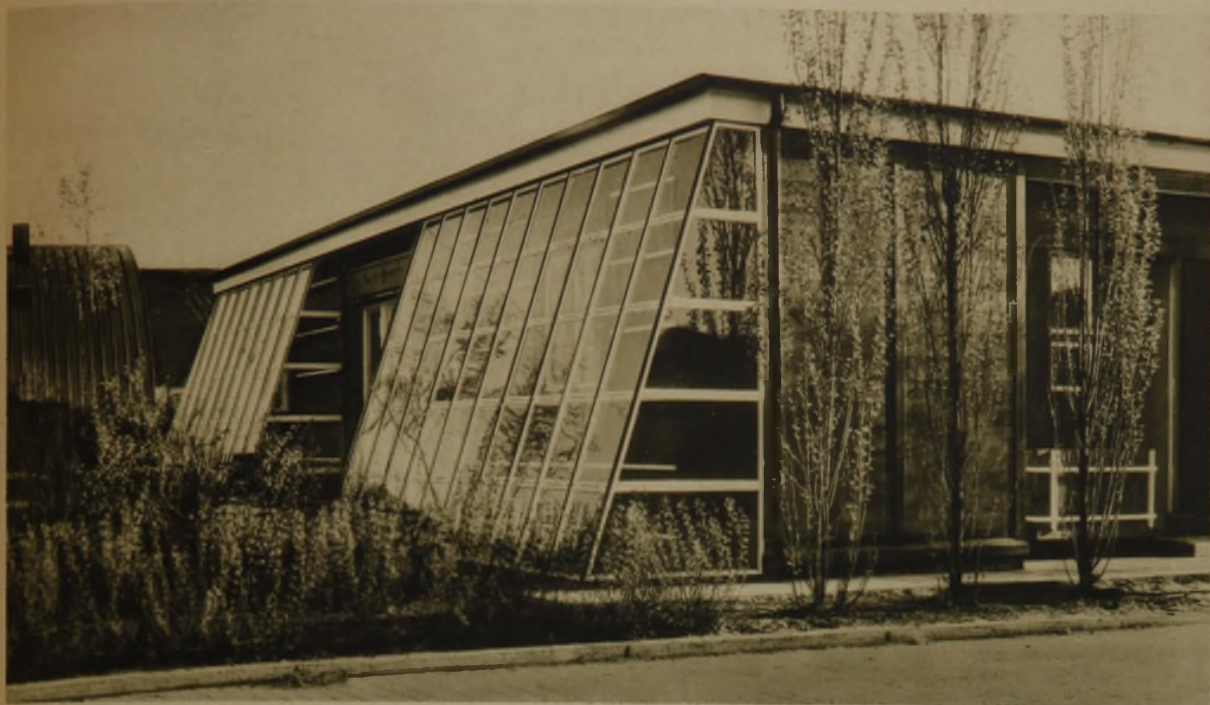
Entwurf Stadtbaurat Dr.-Ing. Martin Wagner. Ausführung Bauhütte Stettin. Ansicht von Nordosten. Sonnen- und Wärmefang, Schallschutz Foto Köster
