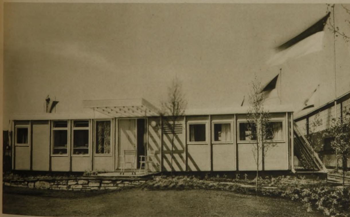
Entwurf Prof. Scharoun, Ausführung Georg Jacobowitz. Ansicht von Süden. Die Plattenrahmen bilden die Tragekonstruktion und bestehen aus einer jalousieartigen Bretterverkleidung, Teerpappe, Luftisolierung, Solomit- und Celotex-Platte. Die Aussteifung der Wand erfolgt durch innen und außen angeordnete Lisenen, die fest miteinander und den Platten verbunden sind. Das Entwurfssystem ist das „Baukaro“, welches die Berücksichtigung der individuellen Wünsche und die Kontrolle der Baukosten gestattet (s. Abb. 1 und 2) Foto Köster
