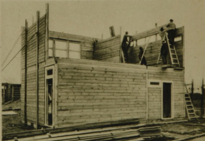
Die Bauelemente der Konstruktion Struzyna D. R. G. M. bestehen aus horizontalen Brüstungs-, Fenster- (Tür-) und Sturzplatten. Die Abbildung zeigt das Einsetzen einer Sturzplatte an der Stirnwand (1. Erweiterung) Fotos Köster
