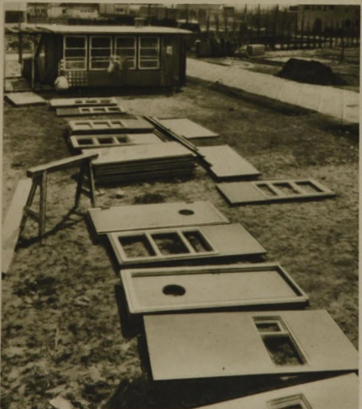
„Werfthaus“. System Bartning G. m. b. H. Das 60-qm-Haus der Ausstellung wurde um 4 Uhr früh in Stettin verladen und um 9 Uhr vormittags, wie die Abbildung zeigt, auf der Baustelle ausgelegt; am Abend desselben Tages waren sämtliche Bautafeln mit Gerippe montiert und das Dach eingedeckt
